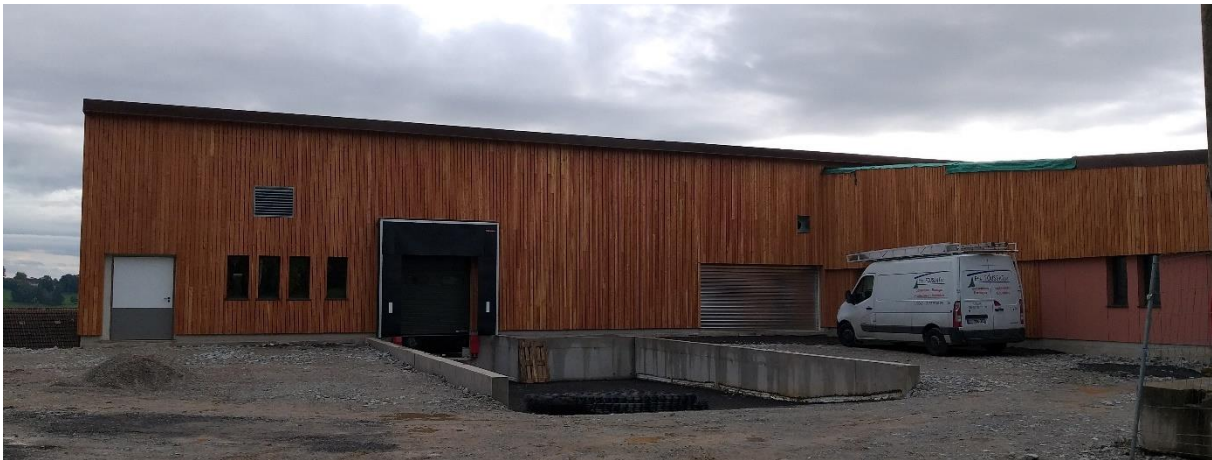
Photo 1 : Site de l'atelier de transformation en fin de chantier
