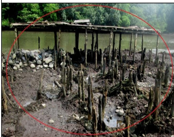
Photo n° 103: Un site d'une construction de Mboko 2 entièrement détruite par les vents.
