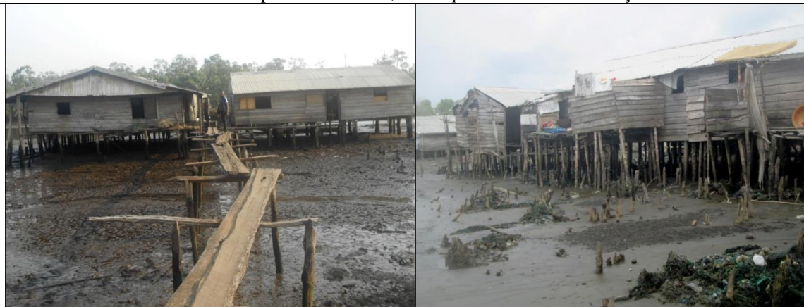
Photo n° 45: Les constructions sur pilotis à Kangué
