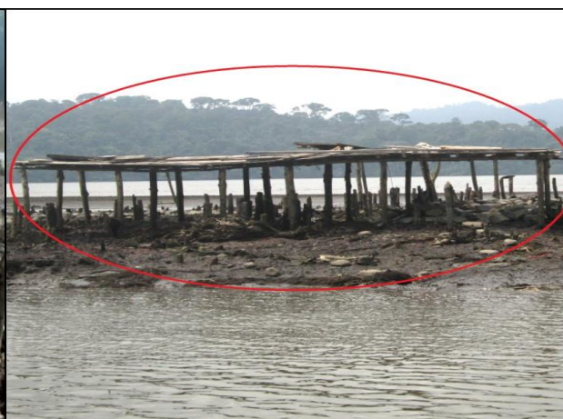
Photo n° 104: Un site d'une construction de Touba entièrement détruite par les vents.
