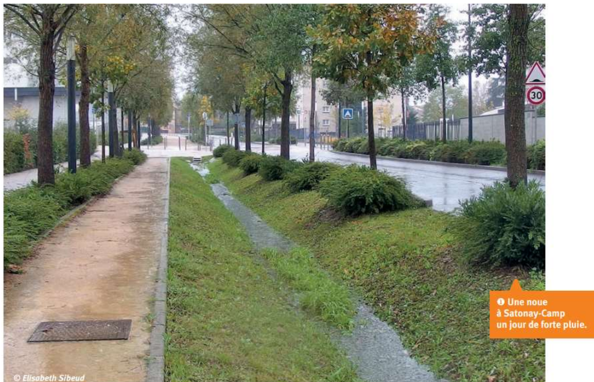
Figure 1.3. Photographie d'une noue (Cherqui et al., 2016)
