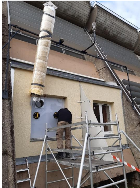
Figure 5-4 : Mise en place du conduit de ventilation naturelle
