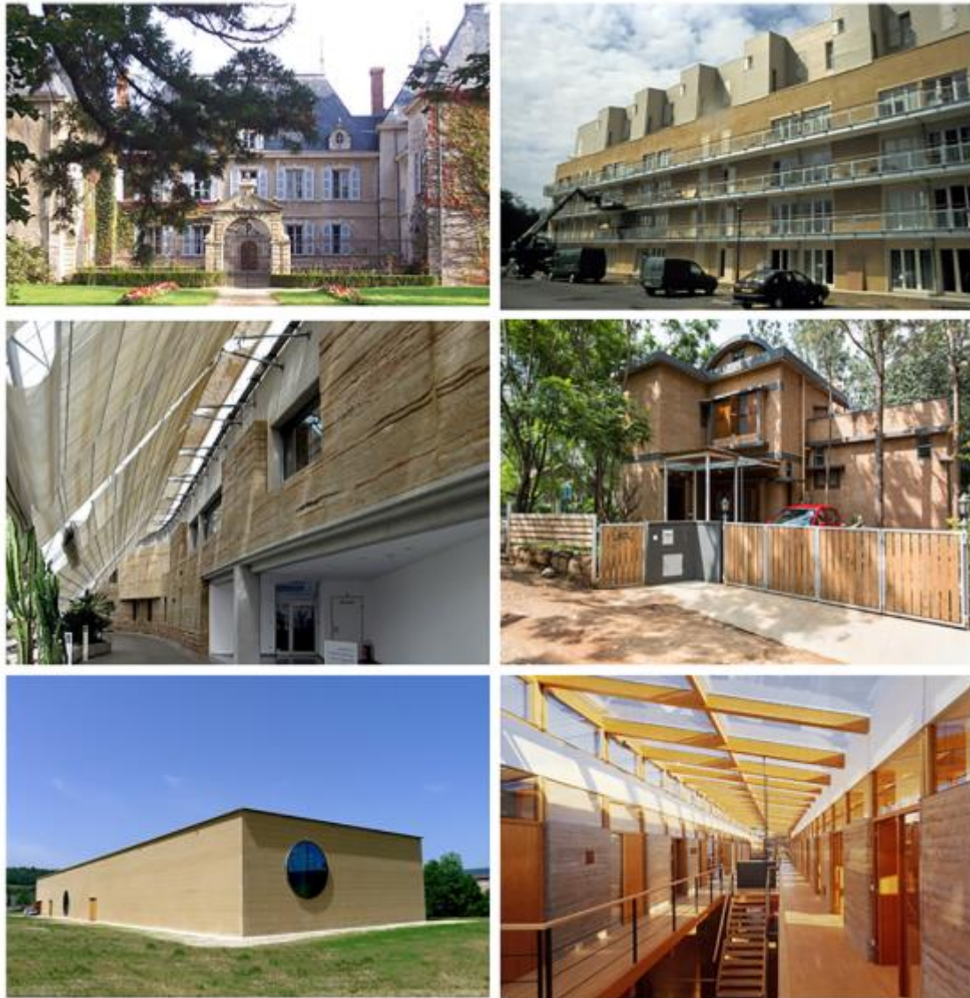
Figure 1 : De gauche à droite et de bas en haut : 1, le château de Vaugirard, Champdieu, France ( www.visitesloireforez.com/château-de-vaugirard ), construit au 17 e siècle en pisé. 2, Salvatierra, bâtiment bioclimatique et passif de 43 appartements, Beaugard, Bretagne, France, 2007. La structure est en béton et la façade est composée de blocs de terre comprimée. Architecte : Jean-Yves Barrier. Photo Ph. Bardel. 3, Hôpital régional de Feldkirch, Vorarlberg, Autriche, 1993. Un mur en pisé de 180 m de long et 6 m de hauteur fonctionnant comme régulateur thermique. Architecte : Martin Rauch. Photo: Bruno Klomfar. 4, Maison privée, Bangalore, Inde. Architecte : Chitra Vishwanath. 5, Centre Ricola Herb, Laufen Suisse, 2014. Façade (100m × 11m) en pisé préfabriqué construit par Lehm Ton Erde GmbH. Architecte : Jacques Herzog & Pierre de Meuron. 6, Entreprise Gugler, Autriche, présence de 160 éléments en pisé. Photo: Bruno Klomfar, Vienne, office@klomfar.com . Issu de : [3].
