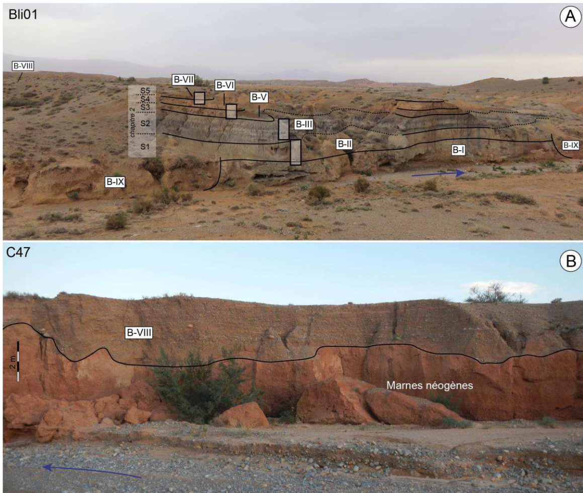
Figure 1-13. A) Vue de la séquence Bli01 et localisation des levés lithostratigraphiques ; B) Vue de la coupe 47 et de la phase B-VIII.
