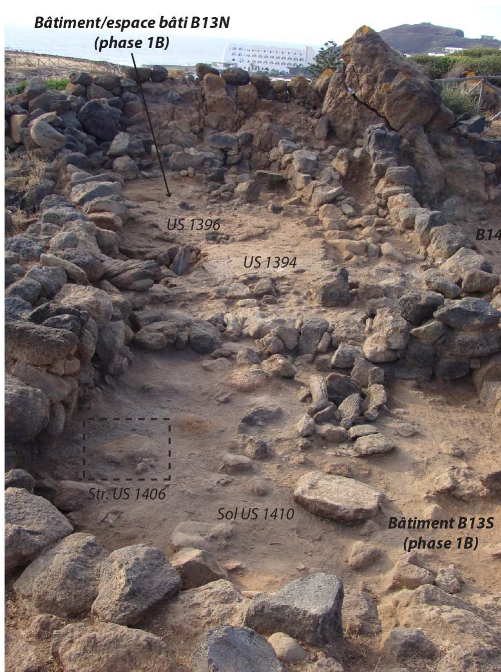
Fig. 4.27 – Vue d’ensemble de la phase 1B des bâtiments B13N et B13S en cours de fouille avec les US et les structures échantillonnées.
