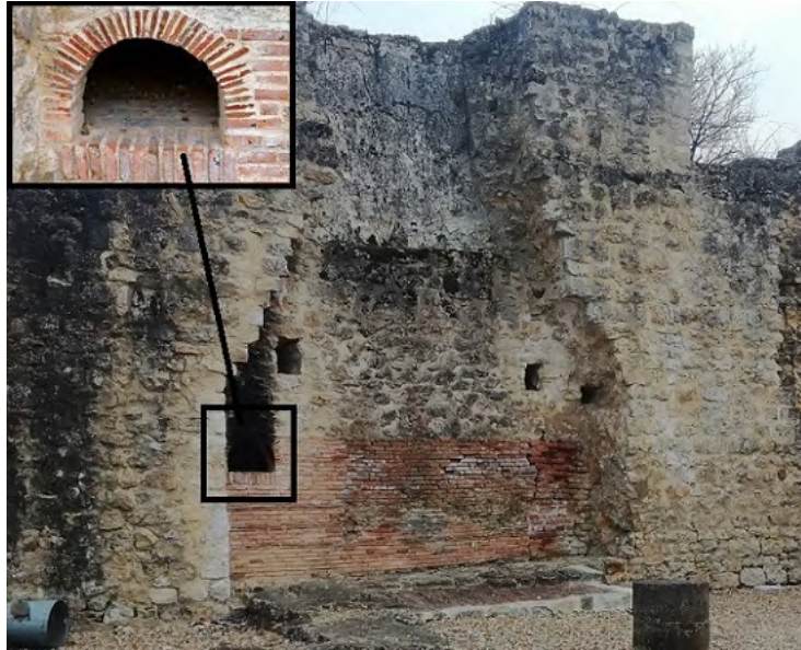
Figure 3.15 – Four (XIVe siècle, restauré) inclus dans la cheminée à Brie-Comte-Robert. (photo d'ensemble : A. Chantran. Détail : www.briecomterobert.fr .)
