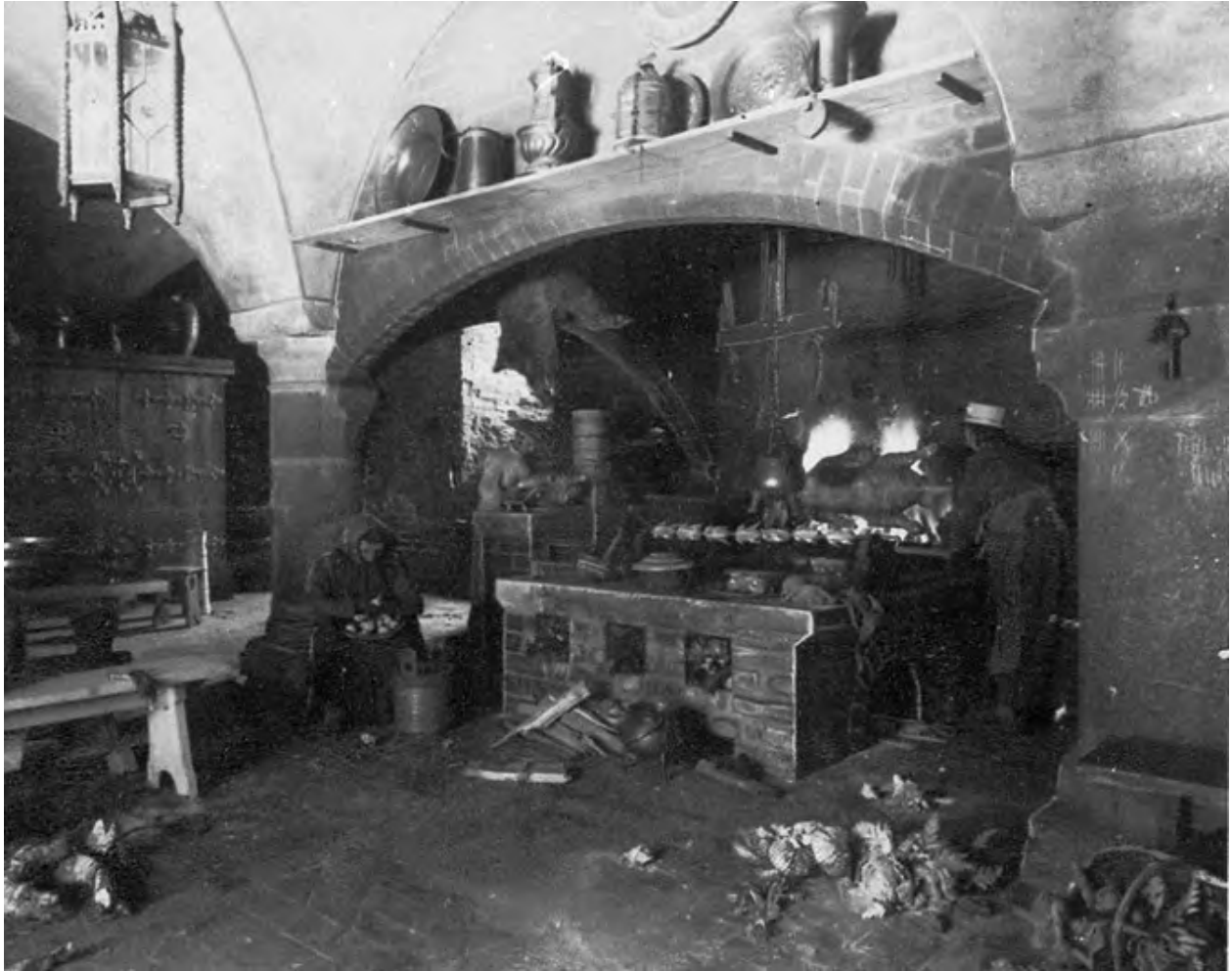
Figure 3.29 – Photographie ancienne de la cuisine de la forteresse teutonique de Malbork qui combine une table de cuisson et des potagers. (Image Bildarchiv Foto Marburg, Aufnahme-Nr. KBB 14.201 (VorschauBild).)
