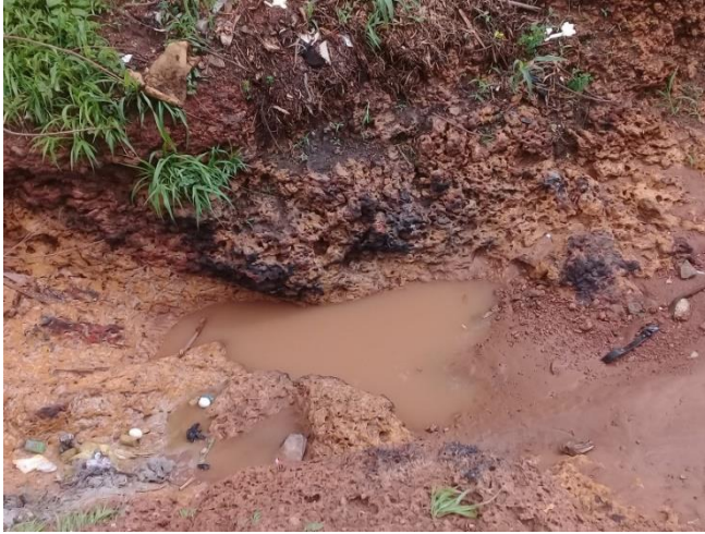
Figure 211 : Les dégâts des eaux de ruissellement sur les routes en latérite à Abattoir (Tambacounda). Clichés : Diouf, 2018.
