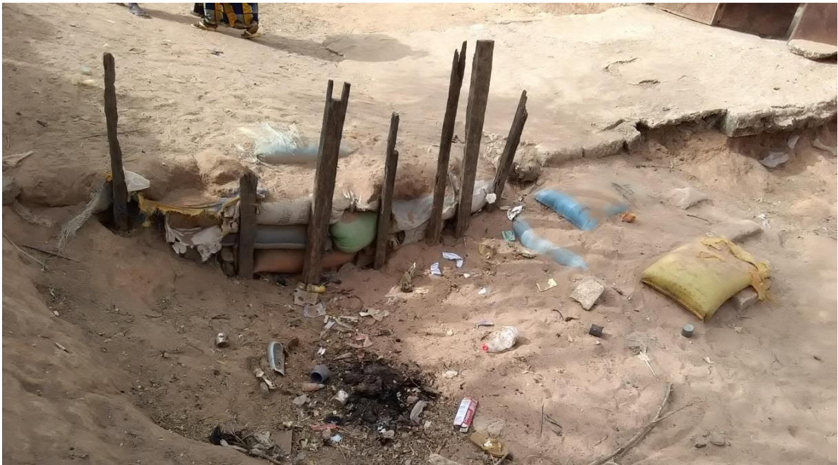
Figure 210 : Technique de protection contre les eaux de ruissellement par les habitants de Colobane (Ziguinchor). Cliché : Diouf, 2015.
