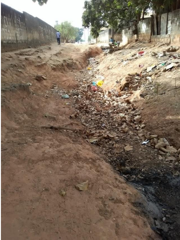
Figure 209 : Les dégâts des eaux de ruissellement sur sol sableux à Colobane (Ziguinchor). Clichés : Diouf, 2017.
