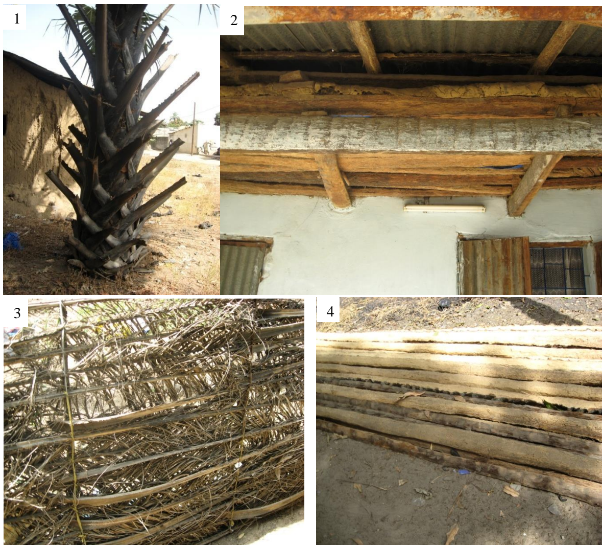
1 : branches de rôniers coupées pour d'autres types utilisations ; 2 : troncs fendus palmier servant de charpente pour un bâtiment ; 3 : clôture fabriquée avec des branches de Rôniers et de Palmier à huile ; 4 : troncs fendus de palmier.
