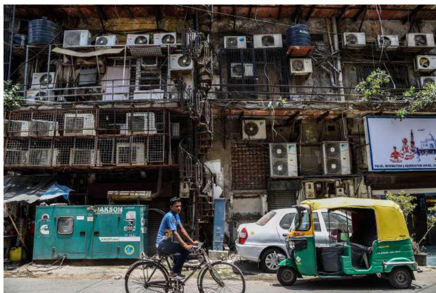
Condizionatori in facciata in una strada Indiana.
