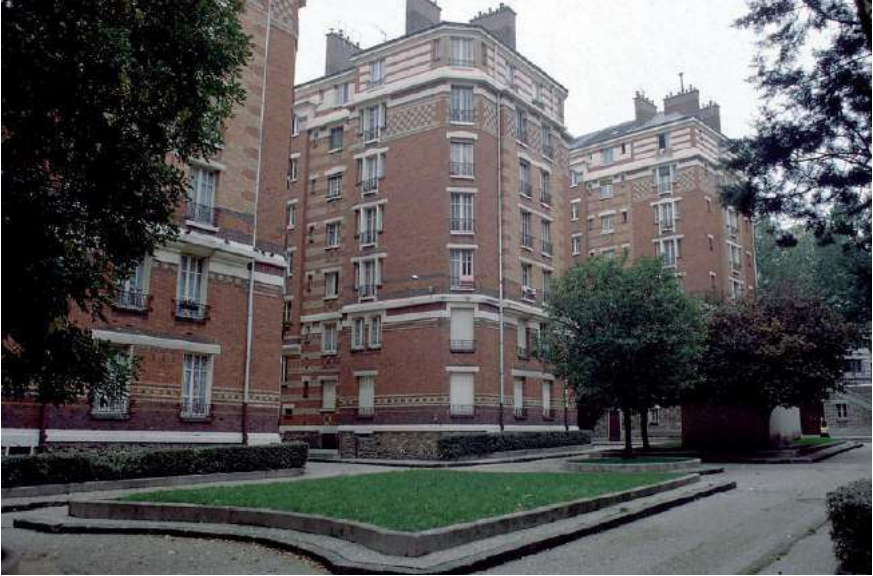
Immobile H.B.M. (Habitation à bon marché) degli anni 1924-30 in Avenue S. Bolivar, Heubés C. Architecte.
