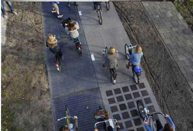
“SolaRoad”, pista ciclabile fotovoltaica. Con soli 200 metri di pista ha permesso di soddisfare i fabbisogni energetici di tre famiglie Fonte: Solaroad
