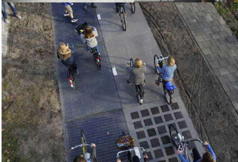
“SolaRoad”, pista ciclabile fotovoltaica. Con soli 200 metri di pista ha permesso di soddisfare i fabbisogni energetici di tre famiglie Fonte: Solaroad
