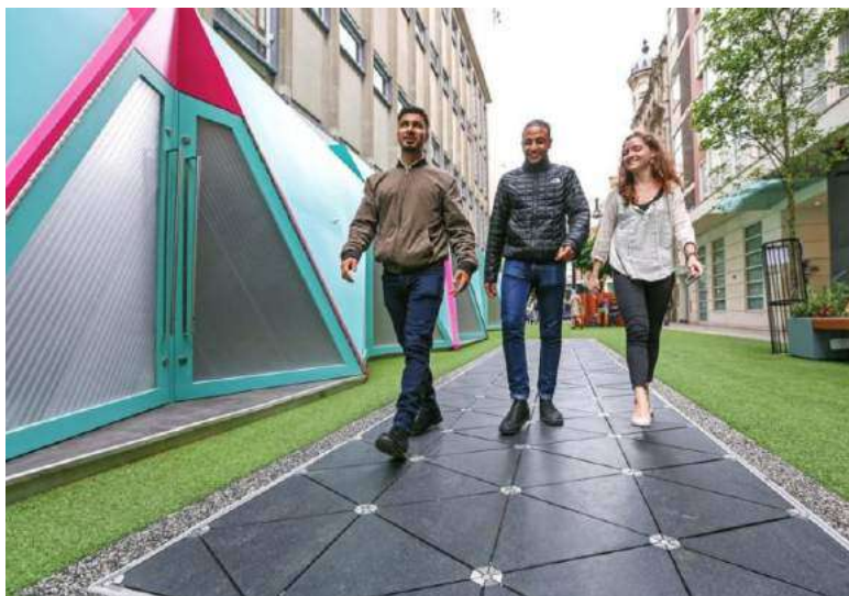
Pavegen. pavimento che converte i passi in energia elettrica da fornire alla rete. Bird Street, Londra. Fonte: Pave- gen
