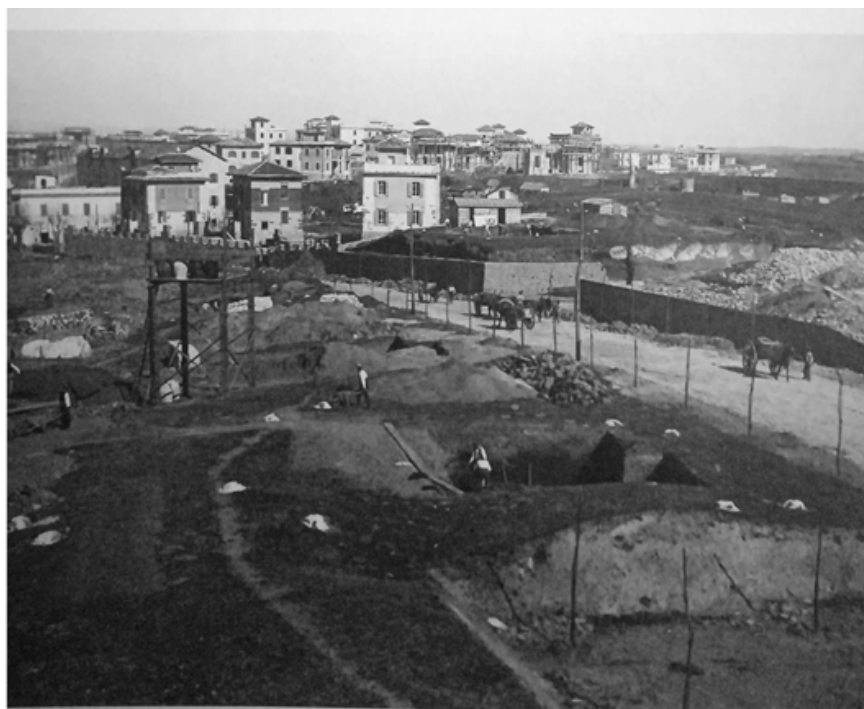
Area di cantiere di alcuni villini della città Giardino Aniene. Fonte: Galassi, Rizzo, 2013
