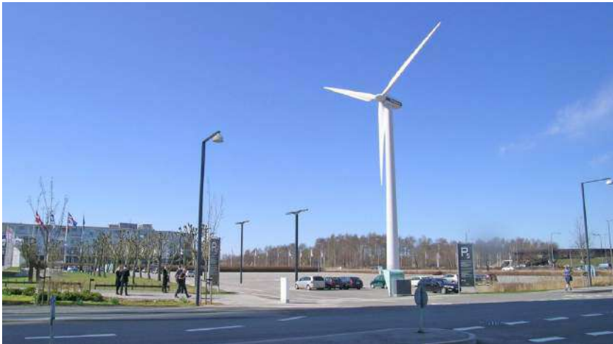
Turbina eolica per la generazione di energia destinata al quartiere, Ørestad, Copenaghen.
