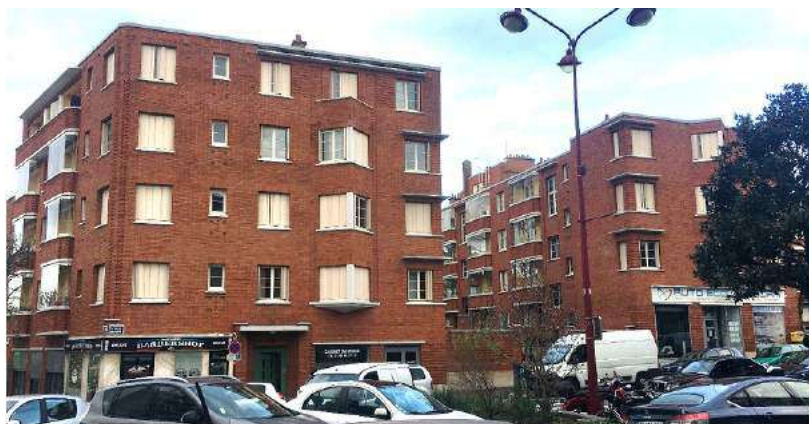
Dettagli architettonici che caratterizzano i prospetti di Place Severine
