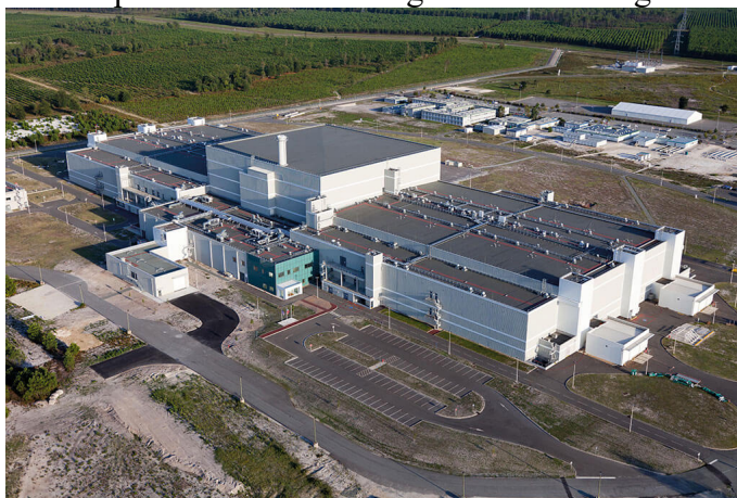
Figure 24 : Vue aérienne de l'installation LMJ-PETAL au CEA CESTA [1]
