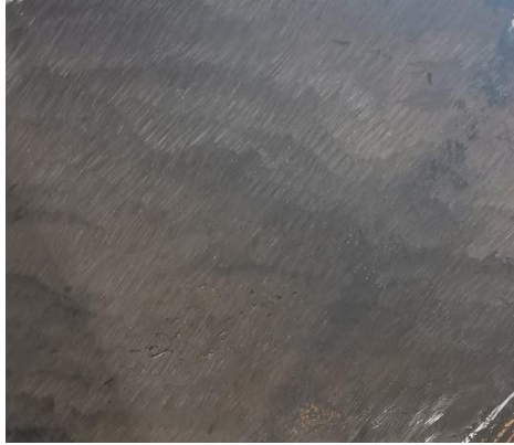
Figure 33 : Exemple de l'aspect visuel d'une surface lisse sans défauts apparents (geste traditionnel)
