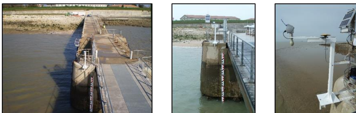
Figure 2.3. Observatoire de l'île d'Aix. Vue d'ensemble sur la jetée Barbotin (gauche), marégraphe et échelle de marée (milieu) et vue rapprochée du système RONIM (droite).
