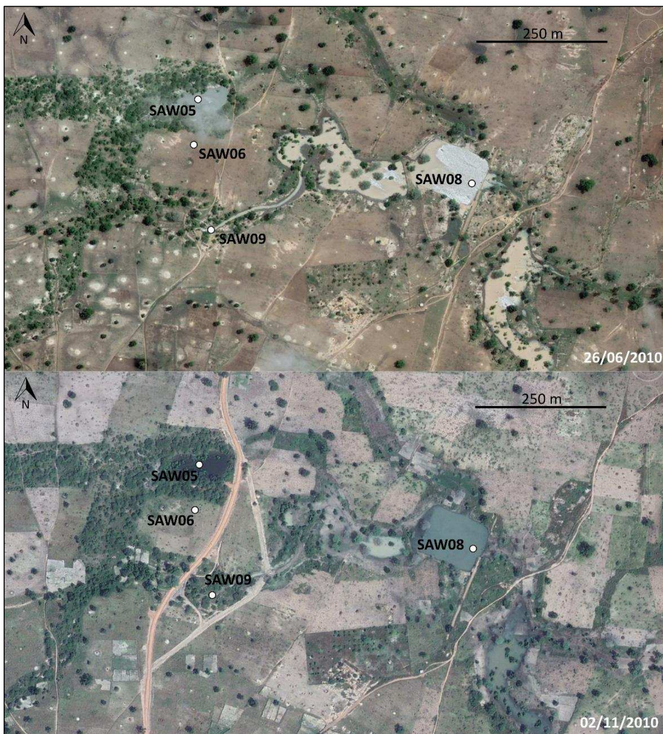
Figure 133. La construction de la route de Sinthiou Wanar, entre le 26 juin et le 2 novembre 2010 (Images Google Satellite).
