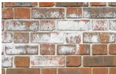
FIGURE 1.12: Efflorescence d'un mur en briques terre cuite
