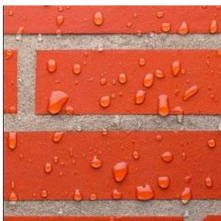
FIGURE 1.17: Principe d'hydrofuge d'une façade
