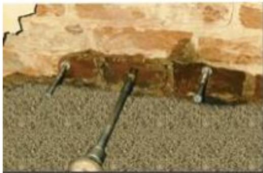
FIGURE 1.18: Mise en œuvre d'une barrière physique jouant le rôle de coupure capillaire
