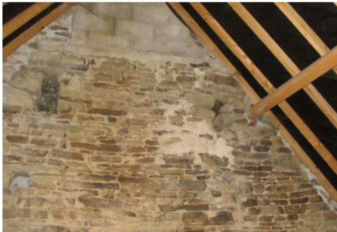
FIGURE 1.9: Exemple d'un pignon en pierres gonflé et fissuré en raison de la présence excessive d'eau
