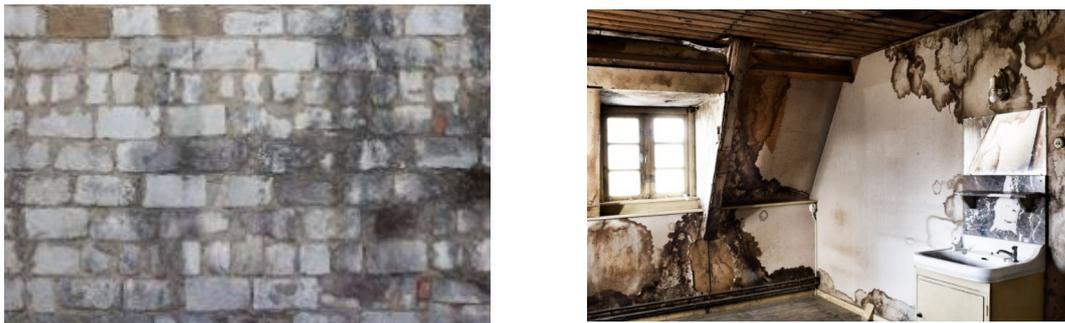
FIGURE 1.14: Développement de bio-contaminants à l'intérieur du bâtiment
