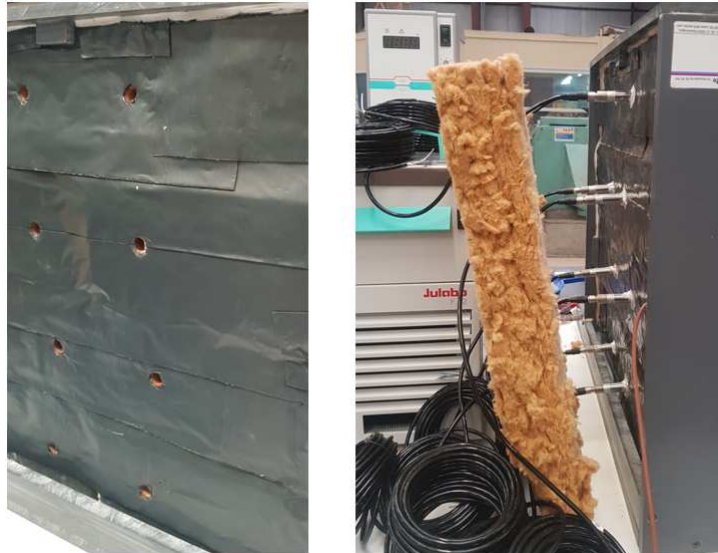
FIGURE 5.6: Mise en place des capteurs sur le mur
