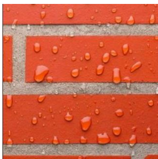
FIGURE 1.17: Principe d'hydrofuge d'une façade
