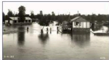
Impasse d'Alsace (vers pont de Jona)
