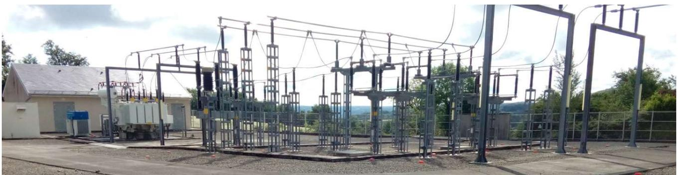
*Figure 1 - Exemple de station électrique avec charpente en acier galvanisé*
