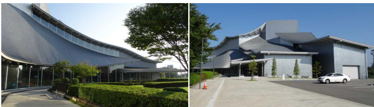
La façade nord-ouest et un mouvement de toiture (5), la façade ouest et le parking (6)
