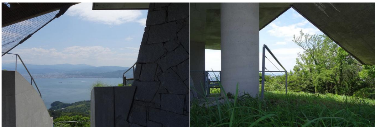
Fig. 94. Observatoire du mont Kiro. Vues sur le panorama et sur les abords. Photographies S. Dousse, 2019/07
