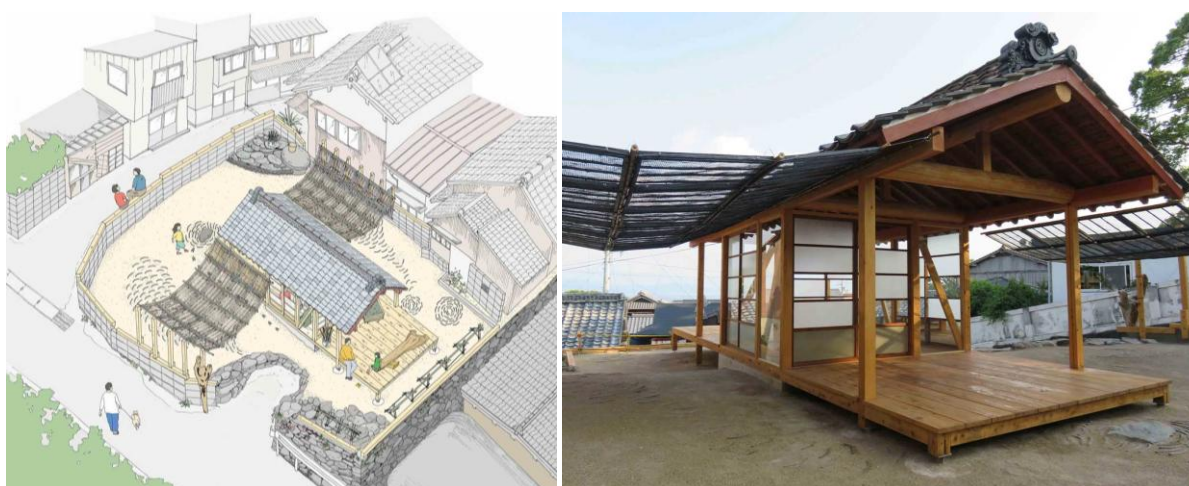
Fig. 120. Pavillon Iriko ou Pavillon de la sardine. De gauche à droite : représentation axonométrique du projet, vue sur le pavillon après achèvement de la construction. Images Manuel Tardits
