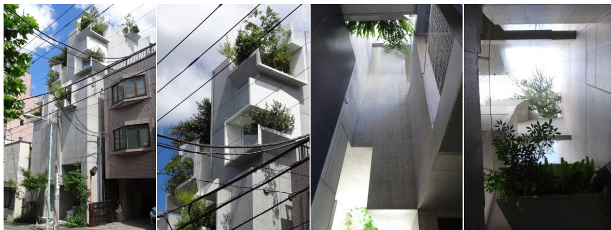
Fig. 90. Tree-ness house. Images de gauche : vues sur la façade principale et ses balcons. Images de droite : vues sur le patio et ses plantations. Photographies S. Dousse, 2019/07
