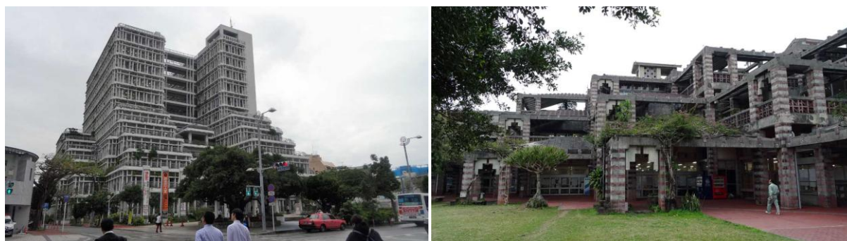
Fig. 147. Le nouvel hôtel de ville de Naha (à gauche) et l'ancien hôtel de ville de Nago (à droite). Photographies S. Dousse, 2018/02
