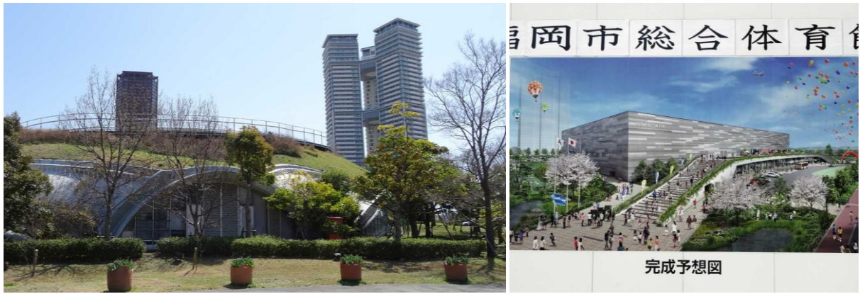
Fig. 55. Complexe éducatif Grin-grin. De gauche à droite : Grin-Grin et son environnement bâti, le futur gymnase de Island City (affichage sur les palissades de chantier). Photographies S. Dousse, 2018/03
