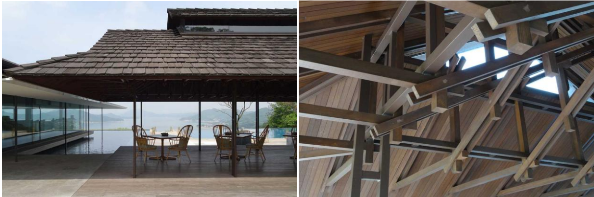
Fig. 113. Restaurant Erretega. De gauche à droite : le restaurant et le panorama de la mer Intérieure de Seto, les assemblages de la charpente. Photographies S. Dousse, 2019/07
