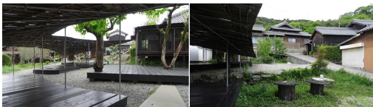
Fig. 133. Le restaurant communautaire Shima-kitchen 531 et son environnement. Photos S. Dousse, 2018/04
