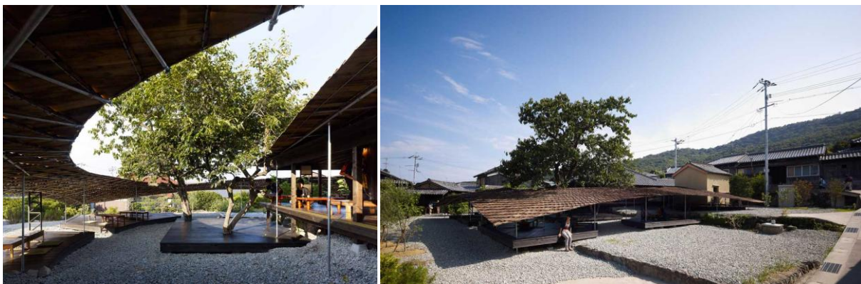
Fig. 119. Shima kitchen. À gauche : l'espace extérieur, la canopée et l'arbre. Photographie Ano Daici. À droite : le bâtiment et le village. Photographie Abe Ryo.
