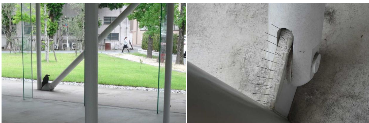
Un corbeau installé sur un pied de poteau (9) et une protection anti-corbeau installée en pied de poteau (10)
