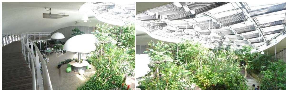
Fig. 54. Complexe éducatif Grin-grin. Passerelle de circulation et serre. Photographies S. Dousse, 2018/03
