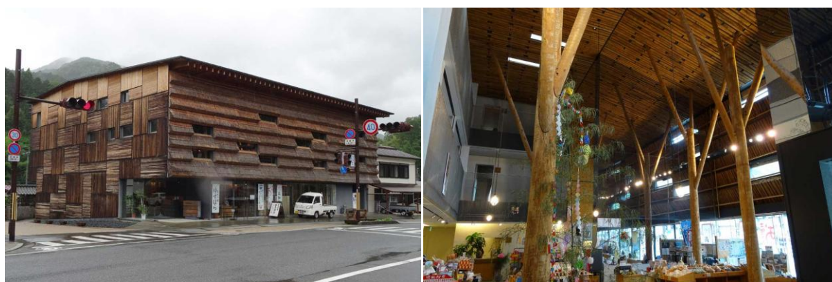
Fig. 107. Hôtel et marché communautaire de Yusuhara. À gauche : la façade principale (en chaume) et l'une des façades latérales (en bois). À droite : l'hôtel (sur la partie gauche) et le marché (sur la partie droite). Photographies S. Dousse, 2018/07
