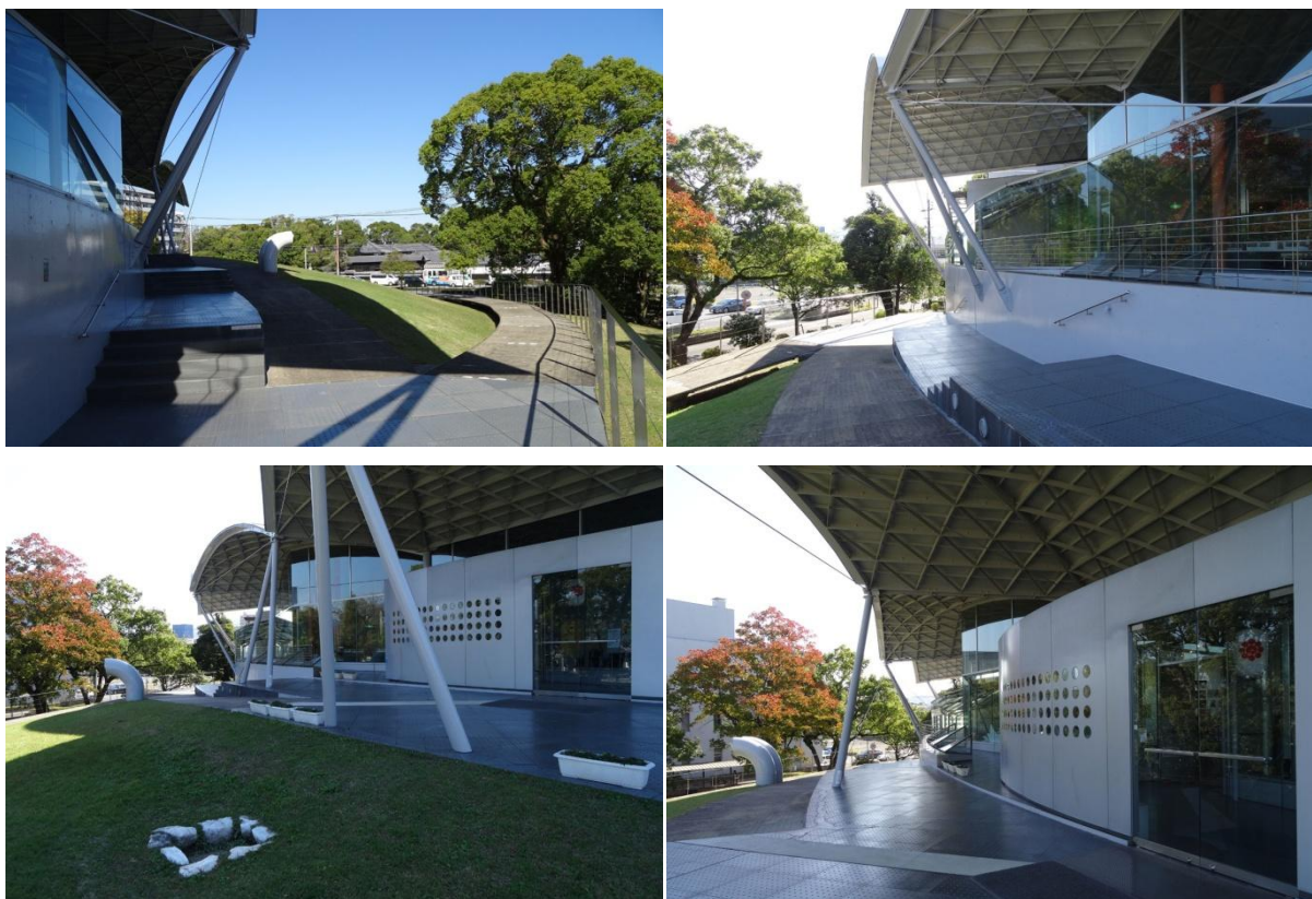
Fig. 30. Musée municipal de Yastushiro. Vues sur la façade nord : voutes de l' « architecture du vent », manches à air, chiriana , pots de fleurs, cheminement et entrée du musée. Photographies S. Dousse, 2019/11
