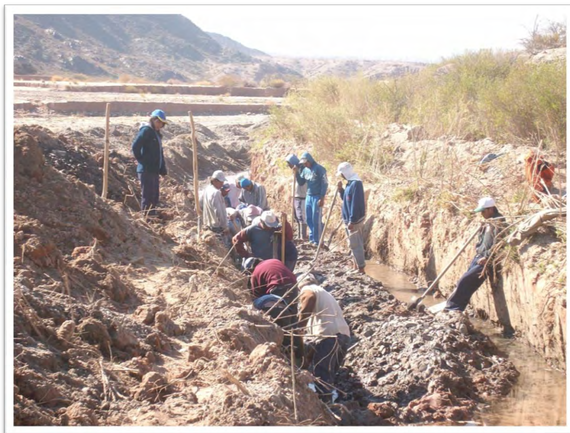
Figura 34: Reparación de la toma de agua para riego.
