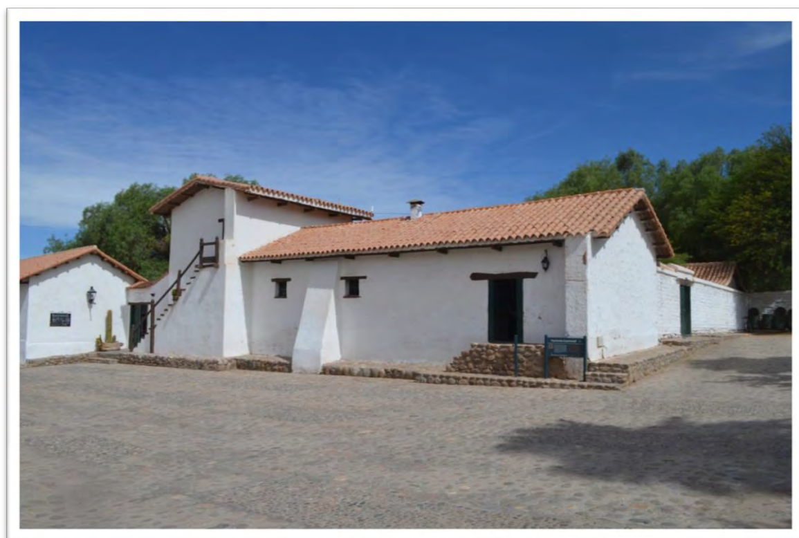
Figura 48: Casa principal de la Hazienda de Molinos en la actualidad.
