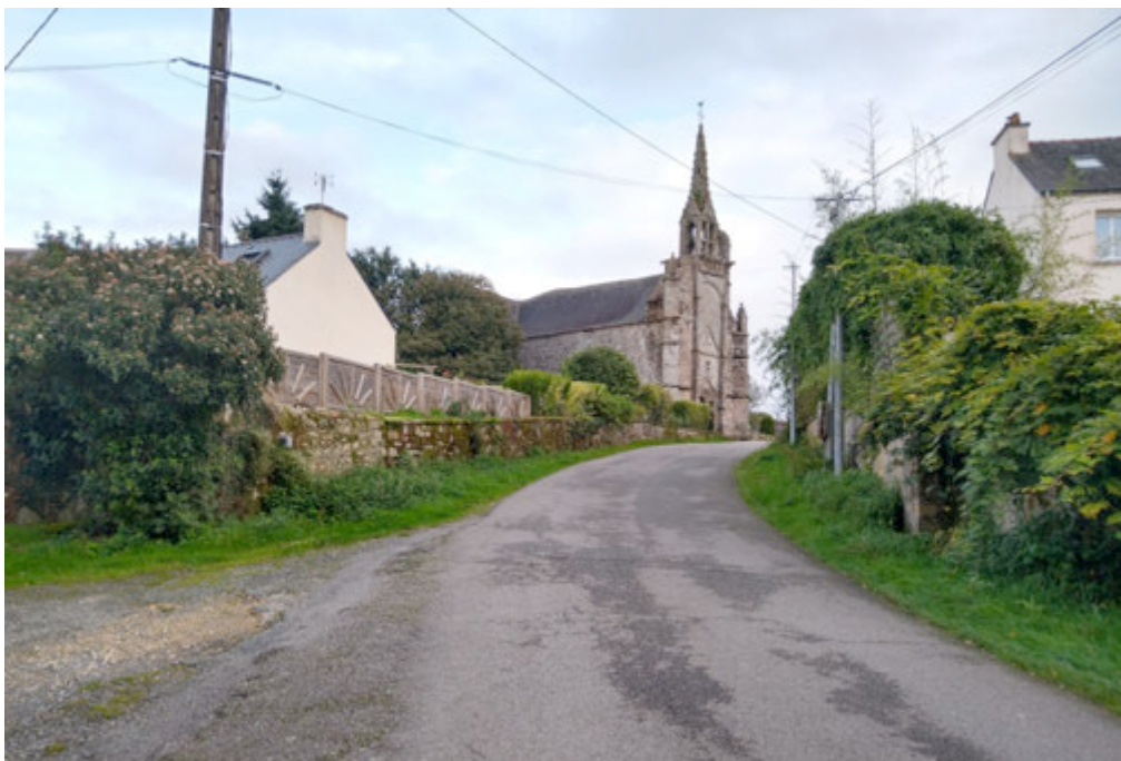
Figure 7 : La montée vers l'église de Locmaria après le passage du vallon, © Charlotte Porcq, octobre 2019
