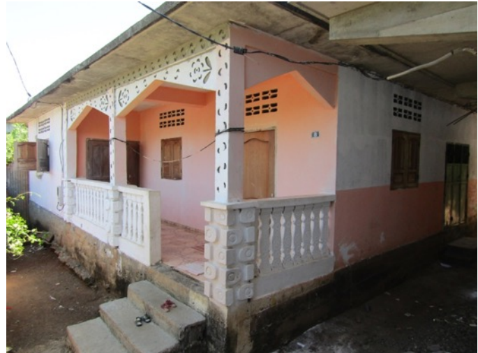
Figure 25 Habitation en bon état avec dalle surélevée de Bambo Ouest (cliché : Issouf Assane)
