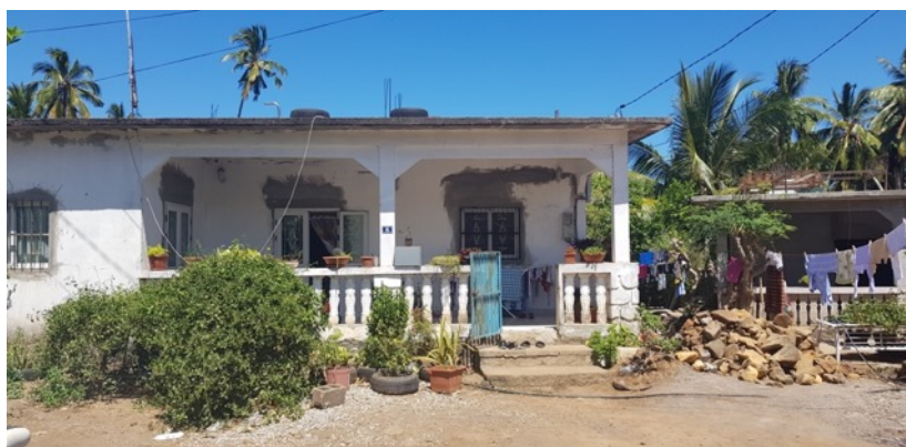
Figure 22 Habitation en bon état de Bambo Ouest (cliché Issouf Assane)
