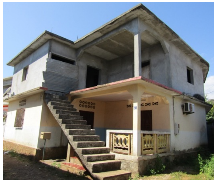
Figure 26 Habitation en bon état en R+1 de Bambo Ouest (cliché : Issouf Assane)
