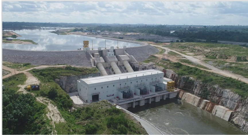
Figure 30. Centrale hydroélectrique de Soubré (Source : CI-Energies)
