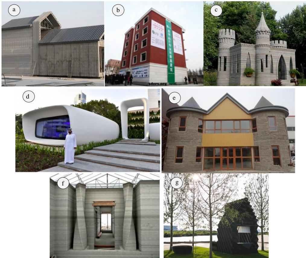
Figure 1-2: (a) Maison imprimée et assemblée par WinSun (Wangler et al. 2016), (b) Immeuble multiétage en Chine imprimé par WinSun ( https://www.cnet.com/ ), (c) Château imprimé en 3D (Bos et al. 2016), (d) Bureau imprimé à Dubaï par WinSun (Ghaffar et al. 2018), (e) Modèle réel de la Maison de Canal ( https://3dprintcanalhouse.com/ ), (f) L'intérieur de l'hôtel imprimé aux Philippines (Ghaffar et al. 2018), (g) Maison de 400 m 2 imprimée à Beijing - Chine ( www.primante3d.com )
