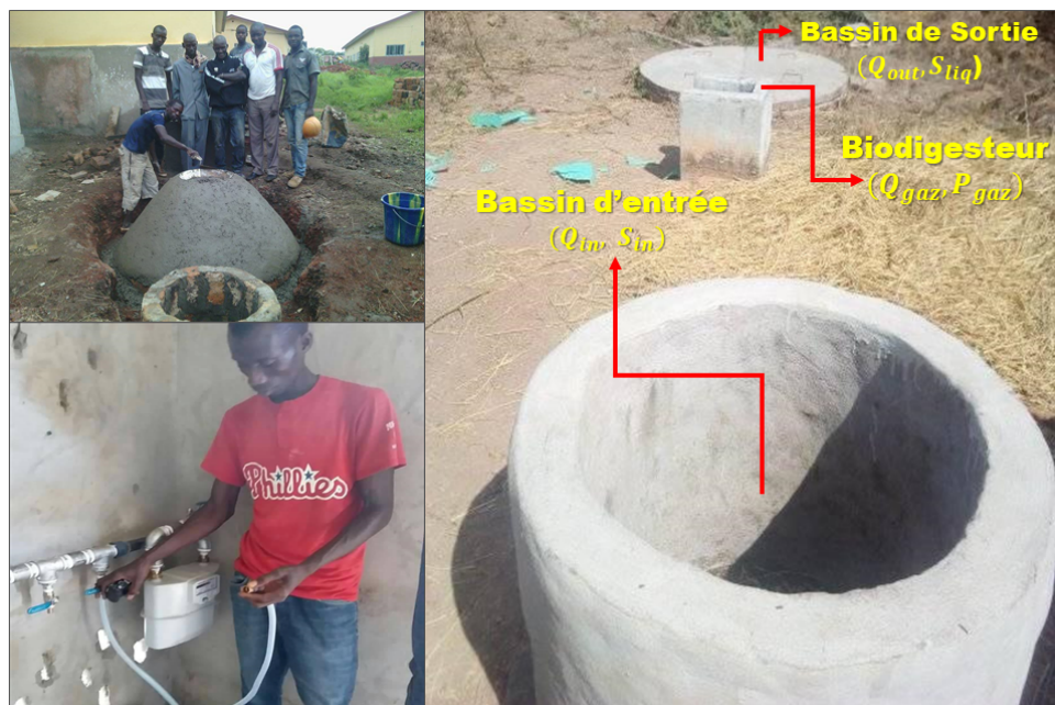
Figure 2.4 – Illustration du digesteur construit à l'IST-Mamou
