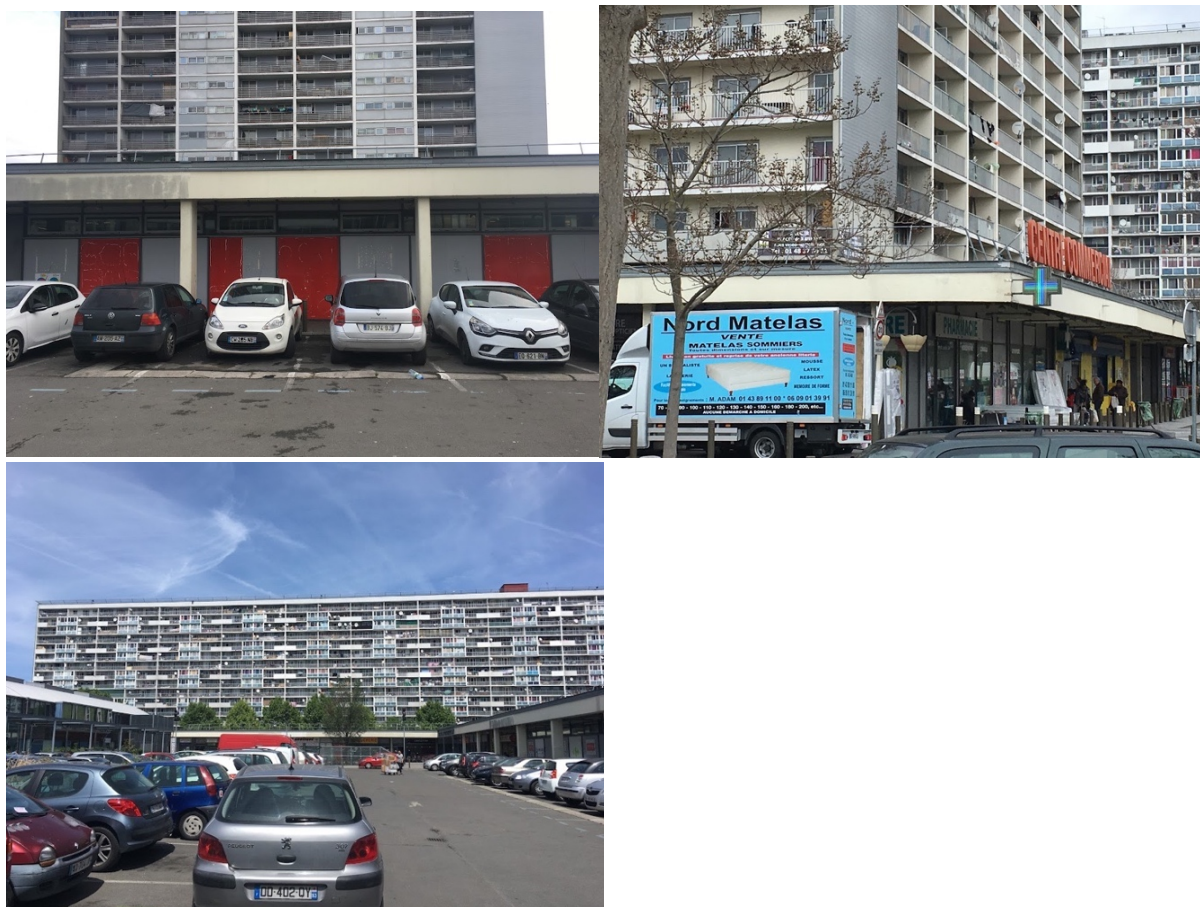
Figure 4.17. Le centre commercial de la Tour. Source : C.H., mars 2018
