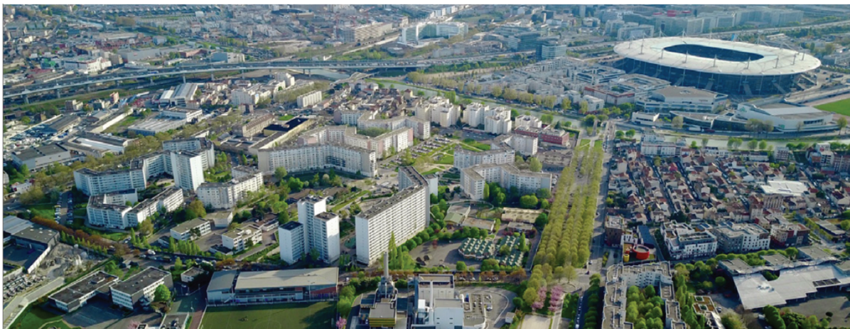
Figure 4.8. Vue aérienne (de l'ouest) du quartier Franc Moisin Source : ONPV, 2019, p.8. Réalisation : Aiman Saad Ellaoui
