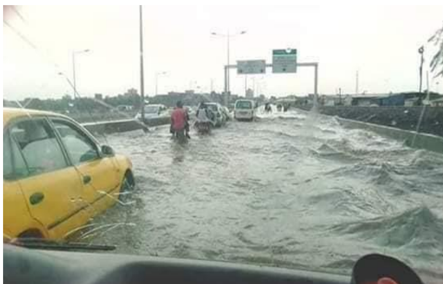
Photo n° 26 : Inondation sur une partie du second pont sur le Wouri
