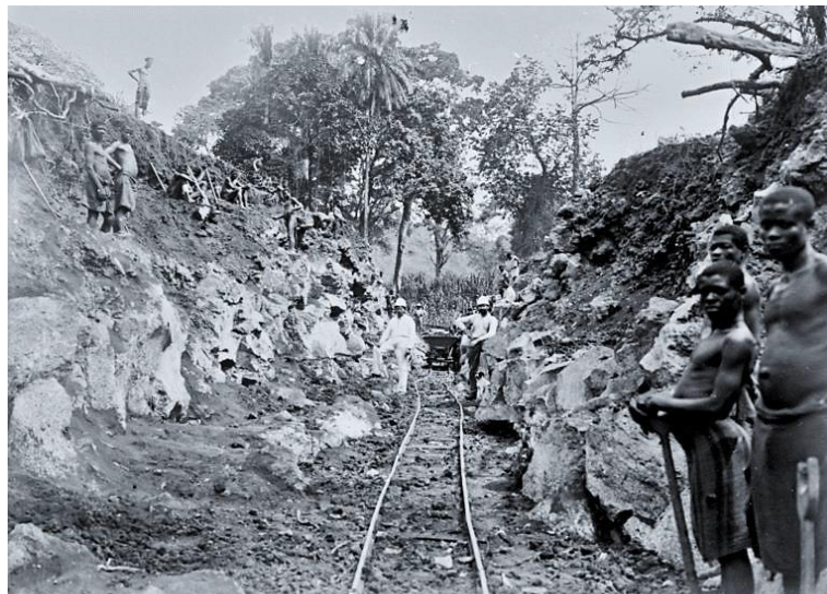
Photo n° 3 : Travaux de terrassement réalisés en 1910 dans la région de Ndunge sur la voie ferrée du Nord
