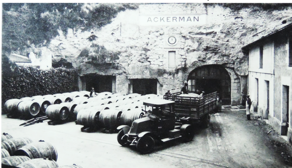
Image 23 : L'inscription du nom de l'entreprise et l'horloge dans la pierre au-dessus de l'entrée des caves Ackerman, vers 1925.
