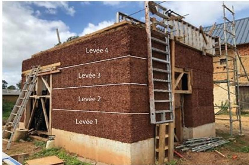
**Figure 78** : Bâtiment pilote avec les différentes levées
