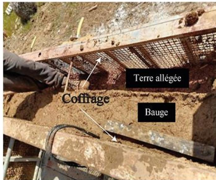
**Figure 51** : Mise en œuvre des mélanges dans le coffrage
