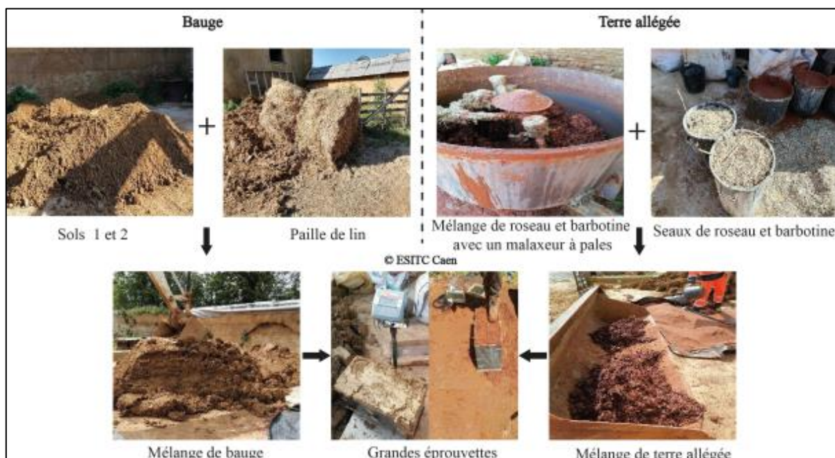
Figure 41 : préparation de la bauge et de la terre allégée sur chantier
