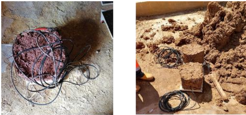
Figure 55 : Préparation des échantillons sur chantier pour étalonnage des capteurs
