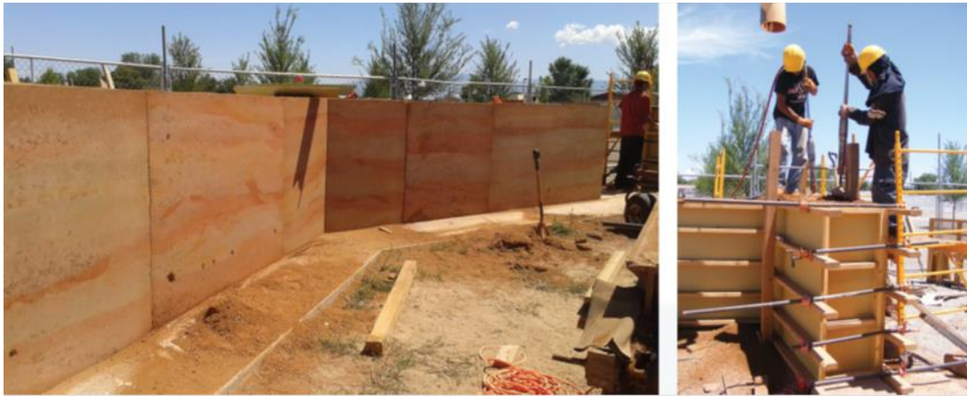
Figure 8 : Construction d'un mur en pisé (Abreu e lima et al. , 2016)
