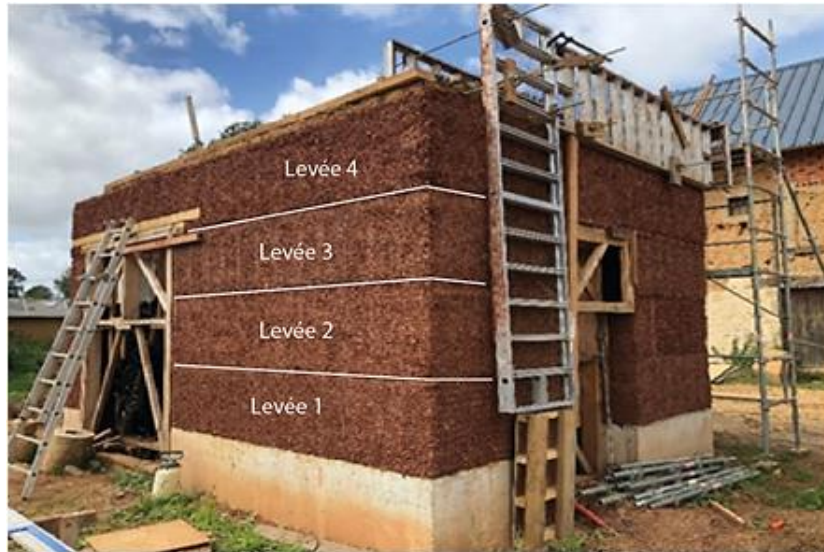
Figure 78 : Bâtiment pilote avec les différentes levées
