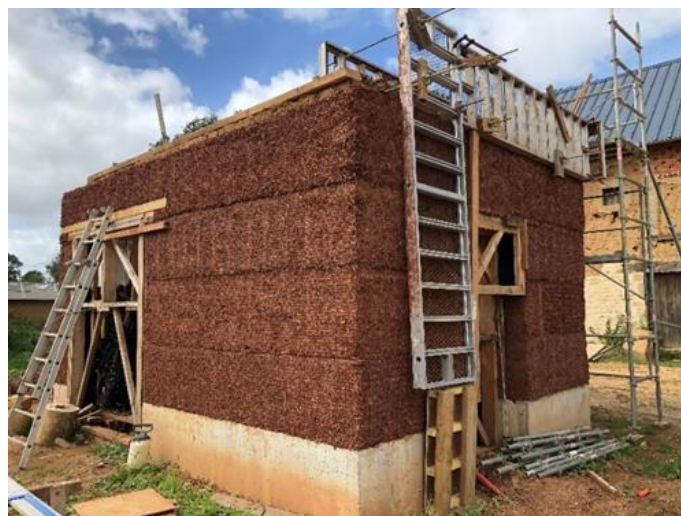
Figure 43 : Bâtiment prototype en cours de construction (projet CobBauge)
