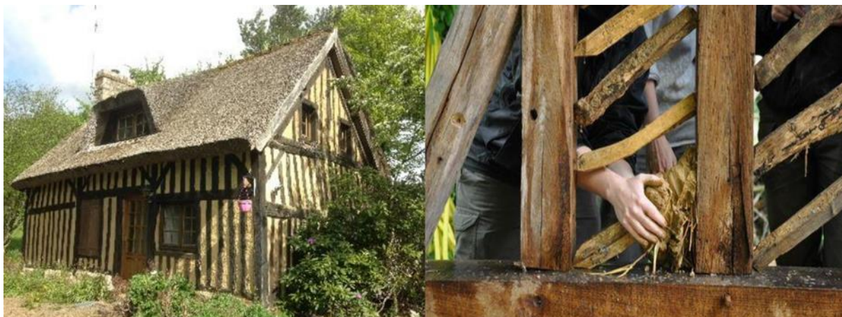
Figure 6 : Maison en torchis pan de bois, Saint-Georges-de-Rouelley (Huret, 2019)
