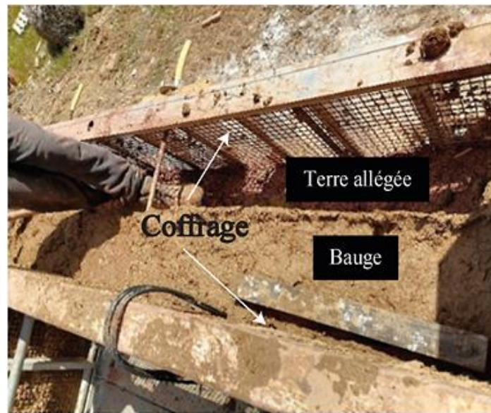
Figure 51 : Mise en œuvre des mélanges dans le coffrage
