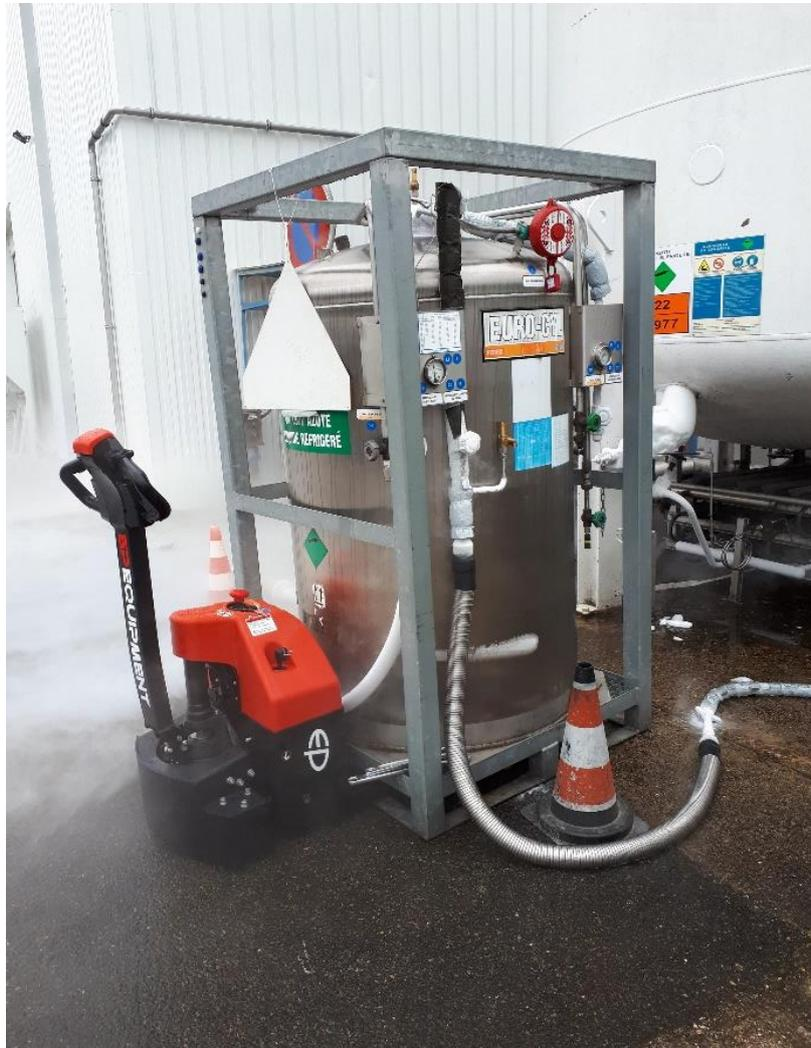
Figure 2.2 : Remplissage du ranger 600L avec de l'azote liquide.
