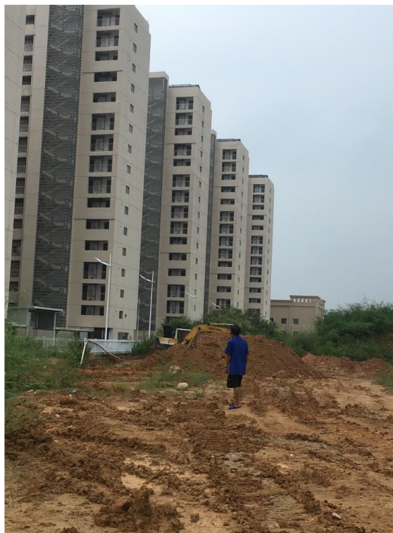
c. Vue de côté des immeubles pour le personnel venu d'ailleurs.
