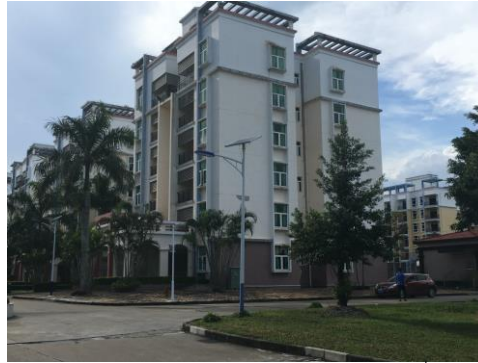
Vue de l'intérieur du parc technologiques V.S.
