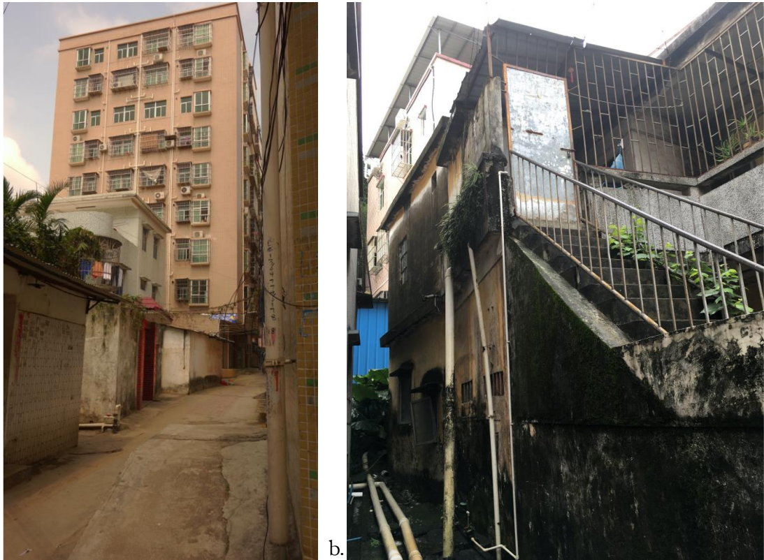
a. Un immeuble de 9 étages dans le Village de Fuxi, Xiangzhou, Zhuhai, 17/5/2017. b. Une ancienne habitation augmentée d'un étage. Village de Jishan, ZDHNT, Zhuhai, 23/8/2018. Source : Photos de l'auteur.
