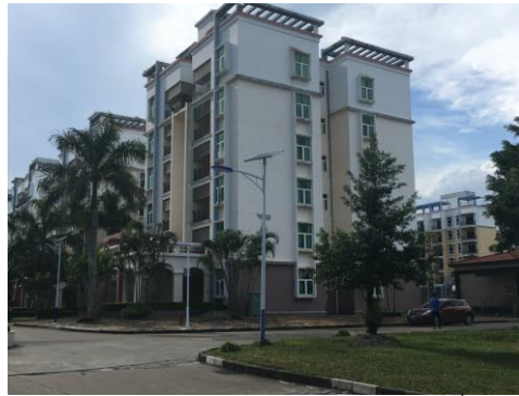
Vue de l'intérieur du parc technologiques V.S.
