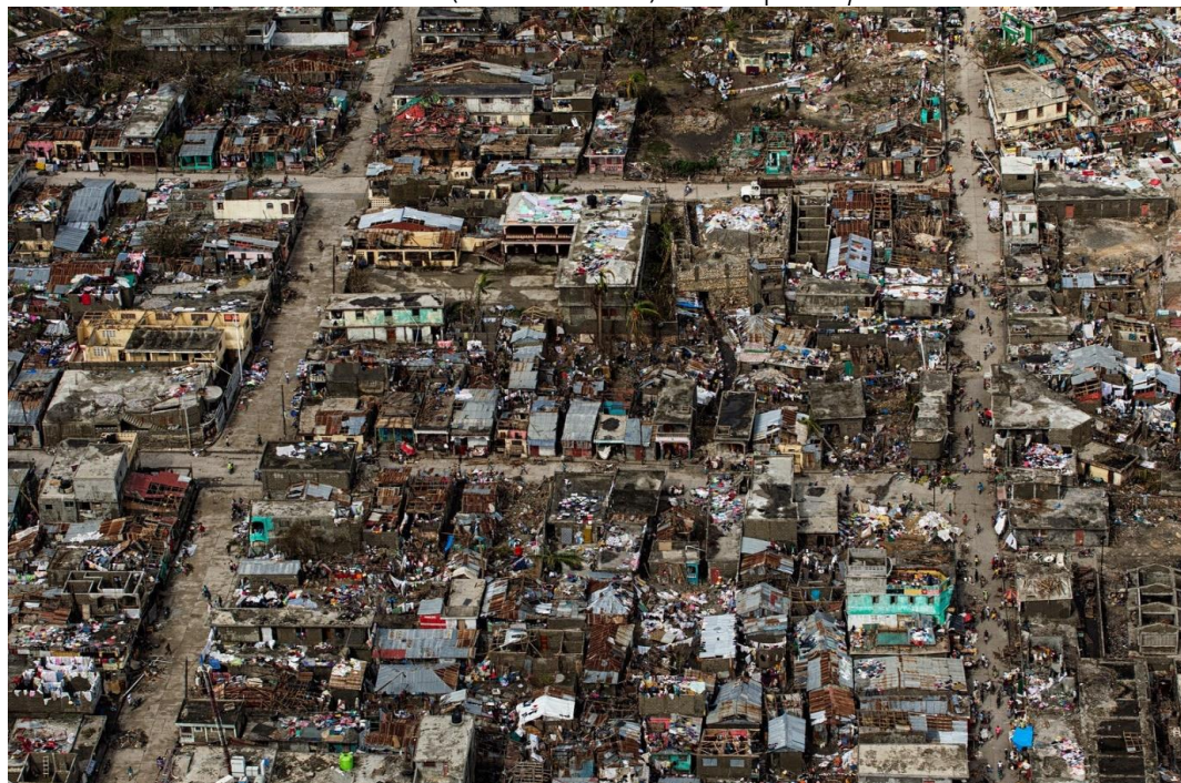
Photo 1.- Ville de Jérémie (Dans la Grande Anse) dévastée après le cyclone Matthew
