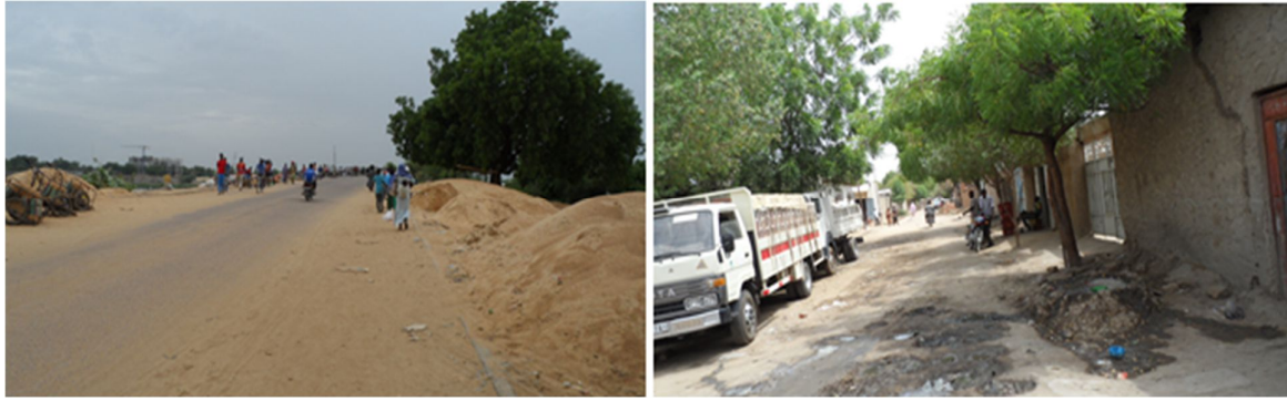
Clichés, Brahim V., 2017. Figure 21 : Le sable stocké, déborde sur la voie bitumée (gauche) et déversement des eaux usées sur la voie publique (droite)
