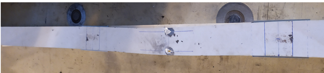
FIGURE II.33 – Poutre AB1.1 - déversement du profilé métallique.
