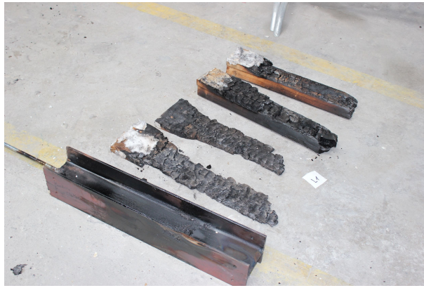
FIGURE III.23 – Essai 1 - éprouvette L1 - bois résiduel après les phases d'exposition au feu puis de refroidissement.
