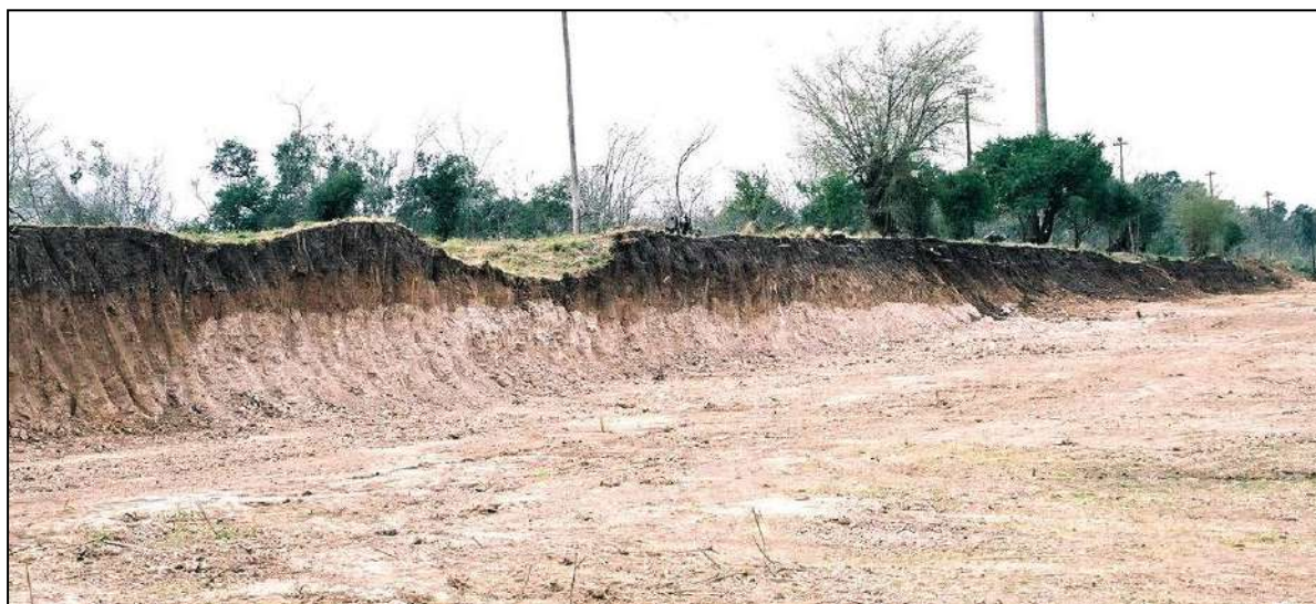
Figure 34. Complexes pédocalciques et ravinement avec remplissage par le loess de l'OIS 2 au toit de la Formation Ensenada. Noter le plongement de la discontinuité vers le centre de la vallée de la rivière Luján (à droite de l'image). Route départementale Luján - Ville Flandria.
