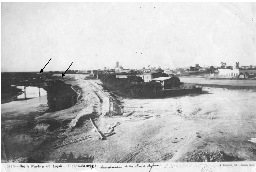
Figure 18. Vue depuis le moulin de Bancalari. On observe encore le pont sur la rue Ituzaingó, derrière le nouveau pont de la rue Mitre (flèches), la construction du talus et l'ancienne église (photo vers 1888, archive Zeballos).
