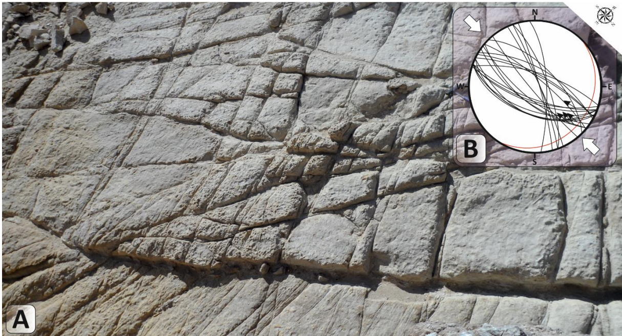
Figure 64: Photographie, représentations stéréographiques et interprétations des fractures mesurées. A : photo de plan de fracture et joints. B : Représentation stéréographique des fractures et de la surface S0.
