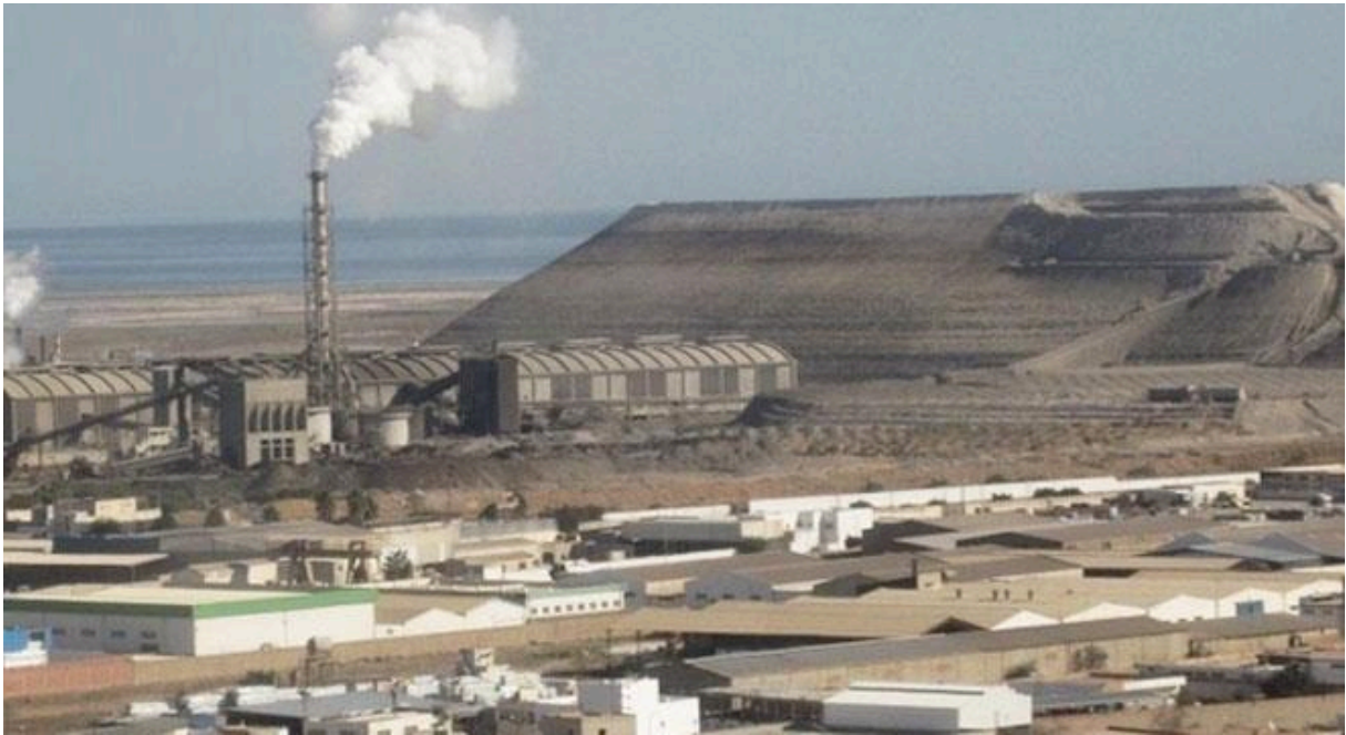
Photographie de l'usine SIAPE, sur le littoral Sud de Sfax. En arrière-plan, le terril de phosphogypse à ciel ouvert.
