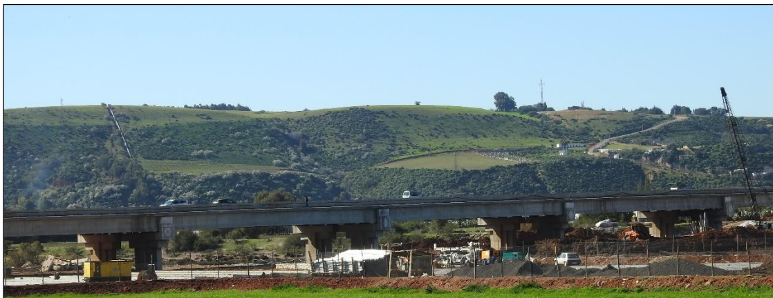
Photo 47 : Autre partie du versant rive gauche avec des façades couvertes de touffes de palmier nain dégradées
