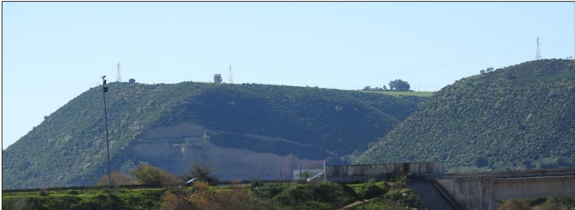
Photo 46 : Versant de la rive gauche : sur la droite, une façade couverte entièrement par des touffes de palmier nain en bon état. Sur la gauche, une partie de la végétation a été entièrement décapée par la carrière.
