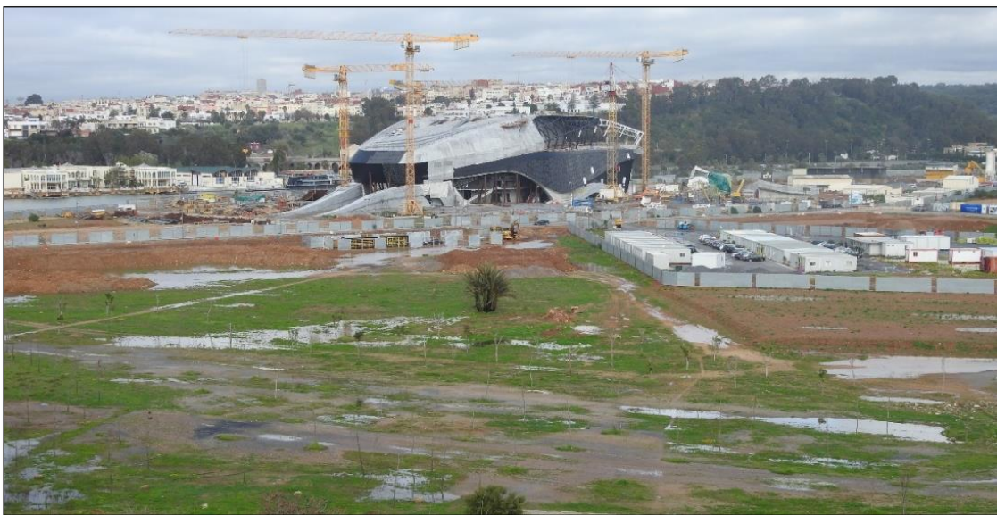
Photo 61 : Photo prise le 06 Mars 2018 après une période pluvieuse montrant au premier plan l'ancienne zone humide de rive gauche, où c'est nettement observable les quantités d'eau stagnante. Au deuxième plan, le chantier de construction du GTR
