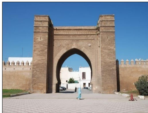
Photo 13 : La Porte du petit port (Bab Lamrissa)
