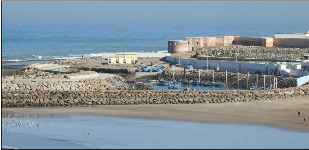
Photo 18: Le nouveau port de pêche située sur la façade atlantique, du côté de Salé
