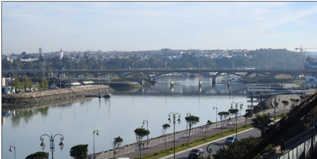
Photo 66 : L'oued Bouregreg au premier plan, et au deuxième plan le pont Hassan II qui marque la rupture de la vue en profondeur sur le cours d'eau
