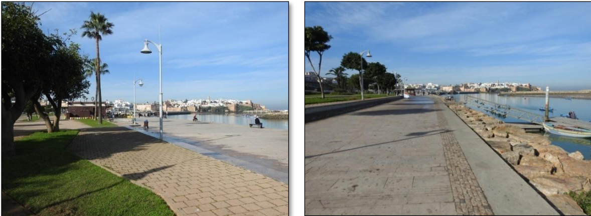
Photo 34 : Différentes vues sur le nouveau quai de Rabat après le réaménagement de 2007
