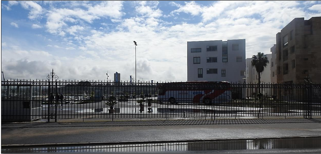
Photo 72 : La clôture autour du complexe de la Marina du Bouregreg
