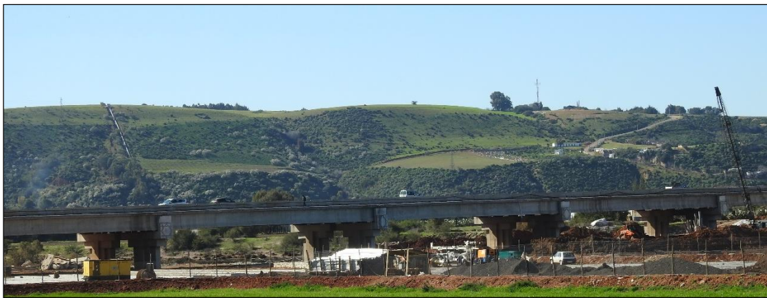
Photo 47 : Autre partie du versant rive gauche avec des façades couvertes de touffes de palmier nain dégradées
