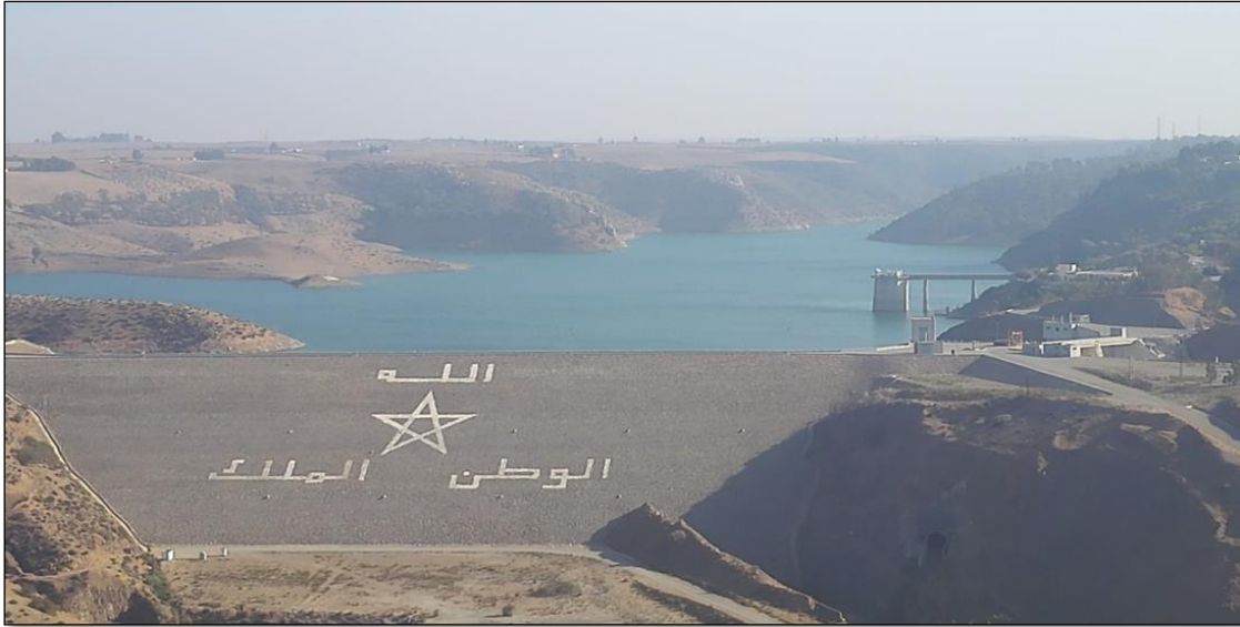
Photo 40 : Vue sur le barrage SMBA après sa surélévation (photo prise en Octobre 2016)
