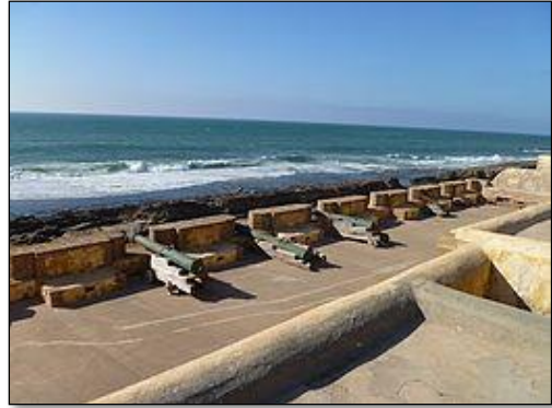
Photo 15 : Bastion des larmes
