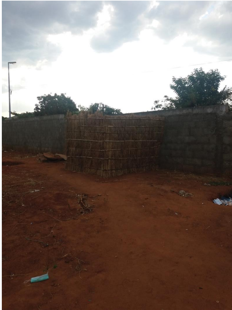
Figure 44: Toilette dans une maternité humanisée, Montpezet.
