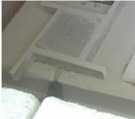
Figure 104 : Plaque d'acier recouverte de placoplâtre
