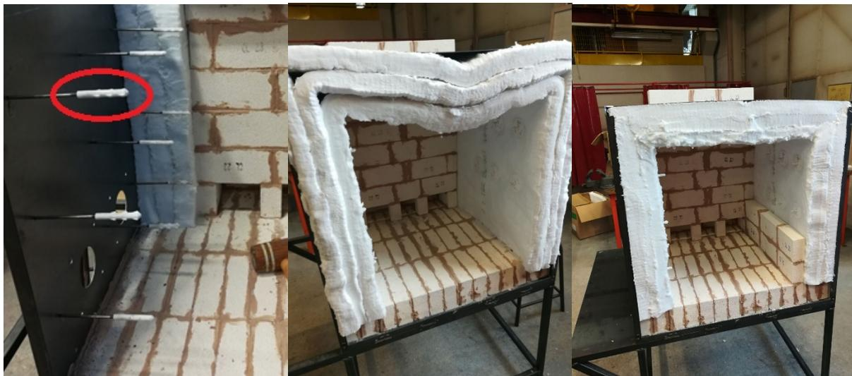
*Installation et fixation de l'isolation des parois latérales et de la voûte au moyen de tiges CERAFIX®*
