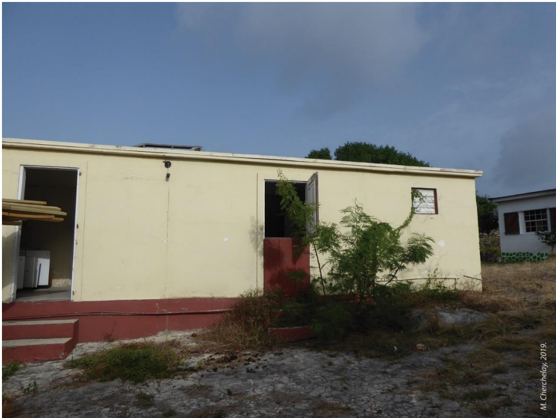
Photographie 49. La maison prise en exemple par l'enquêtee (Entretien n°52, 2019), illustrant la simplicité des modes de construction anciens.
