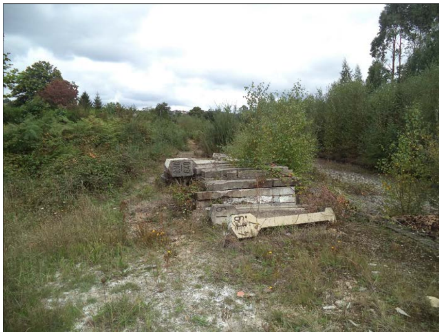
Restos de señales ferroviarias en la antigua estación de Queixas-Londoño. A la derecha de estas, el trazado desmantelado. Autor: Varela Cornado (2017)
