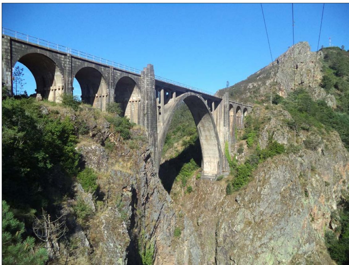
Figura 3 – Puente de Gundián sobre el río Ulla en la línea convencional Ourense-Santiago Fuente: Varela Cornado (2015)
