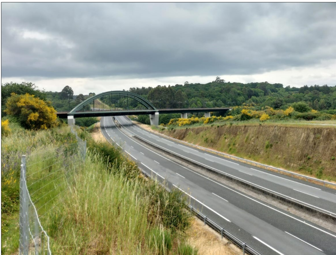
Figura 30 – Autopista AP-53 en el municipio de Lalín (Pontevedra) y paso superior de la LAV Santiago-Ourense.
