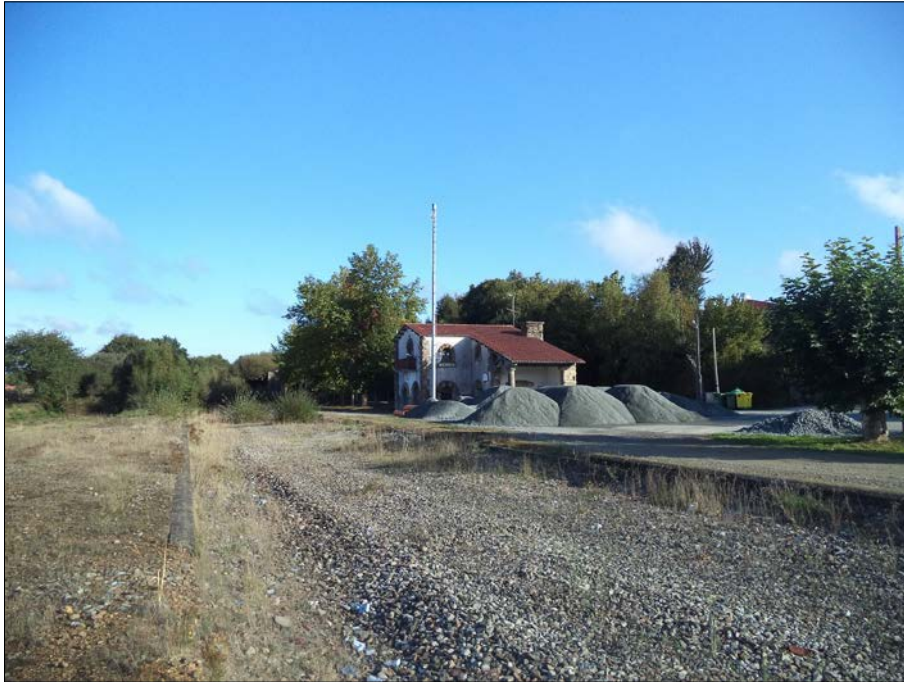
Restos del trazado de la antigua línea convencional Santiago-A Coruña en la estación de Verdía (Santiago de Compostela). Autor: Varela Cornado (2017)
