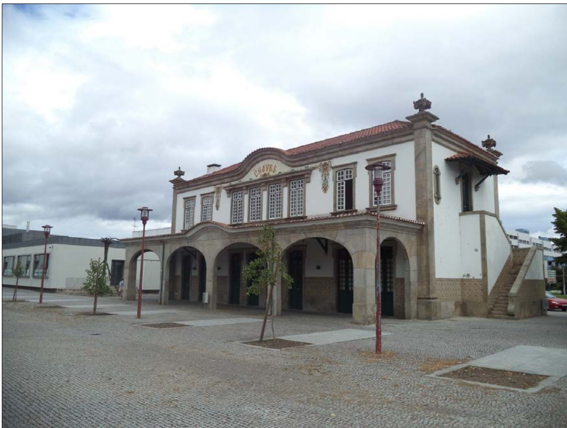
Figura 42 – Estación ferroviaria de Chaves (Portugal) en la actualidad.
