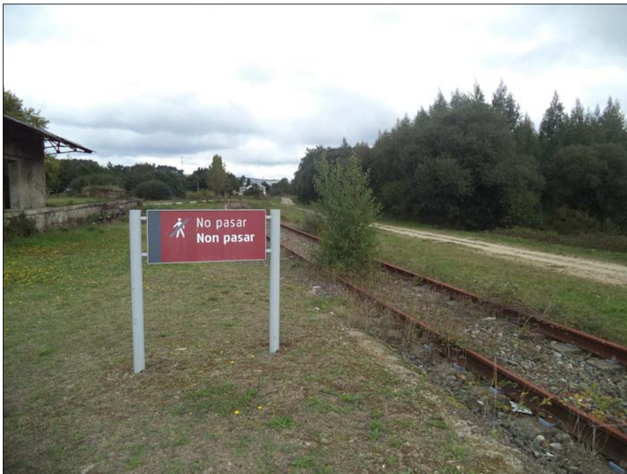
Vías sin levantar de la antigua línea convencional Santiago-A Coruña en la estación de Cerceda. Autor: Varela Cornado (2017)
